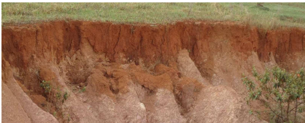
Figura 9 - Contato entre material oriundo das Coberturas Elúvio-Coluvionares do Terciário e do material oriundo da Formação Lagoa Formosa em voçoroca no município de Lagoa Formosa, Minas Gerais.
