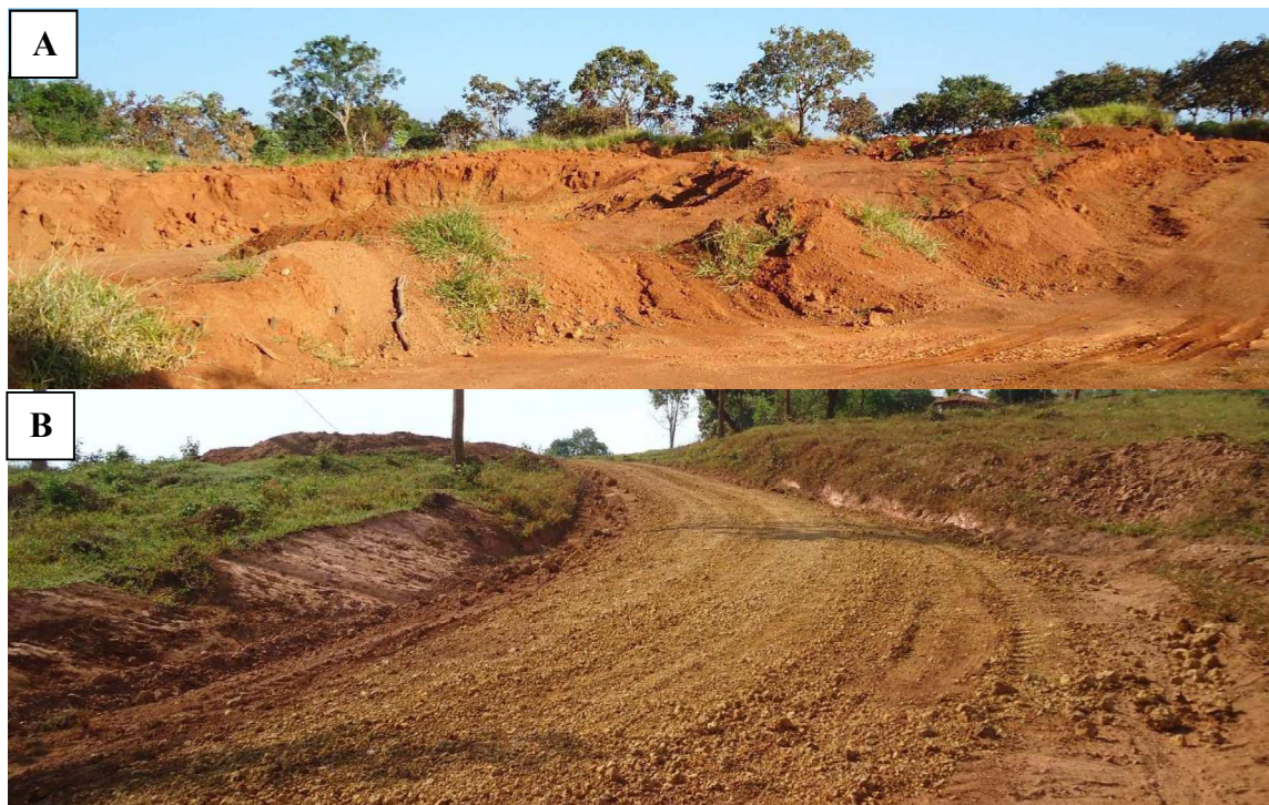
Figura 17 - Cobertura laterítica. (A) Retirada da cobertura laterítica. (B) Uso do material laterítico para capeamento de estradas.
