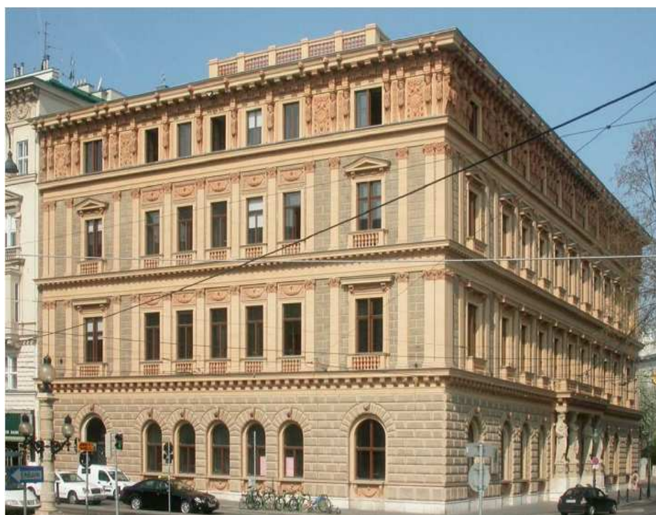
Figura 2.1 – Fachada do edifício Palais Epstein, Vienna (1868-72), com reboco externo em argamassa de cimento Romano sem pintura e ornatos de peças cerâmicas
