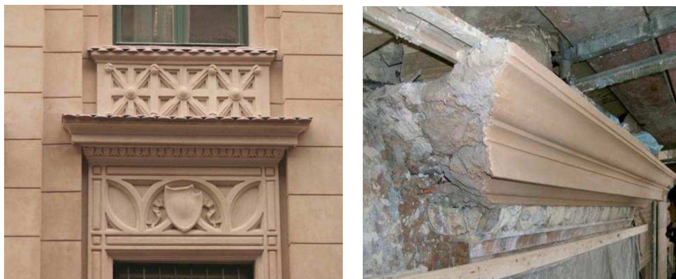
Figura 3.1 – Fachada de edifício restaurada em cimento romano e friso em execução
