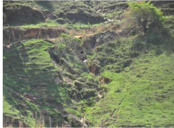
Figura 12: processos erosivos na área da escarpa.
