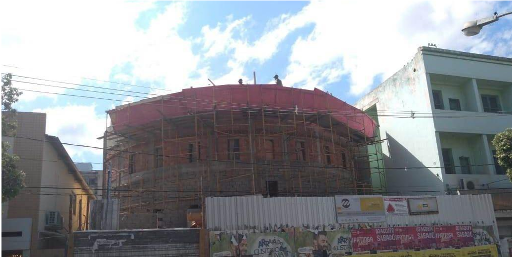
Figura 20 – Cine Brasil com fachada sendo reconstruída, em 04/09/2019.
