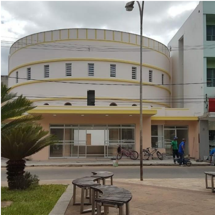
Figura 22 - Retirada dos Tapumes, obra quase finalizada, 22/12/2019.
