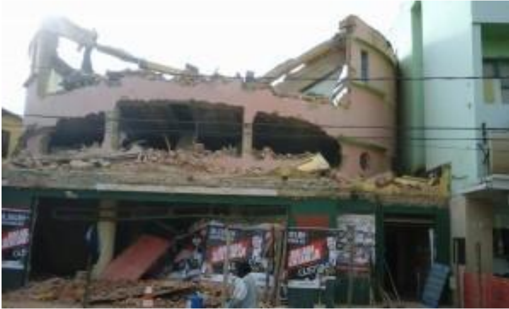
Figura 12 - Cine Brasil quase que totalmente demolido.
