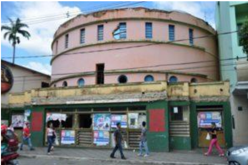
Figura 11 - Cine Brasil parcialmente demolido.
