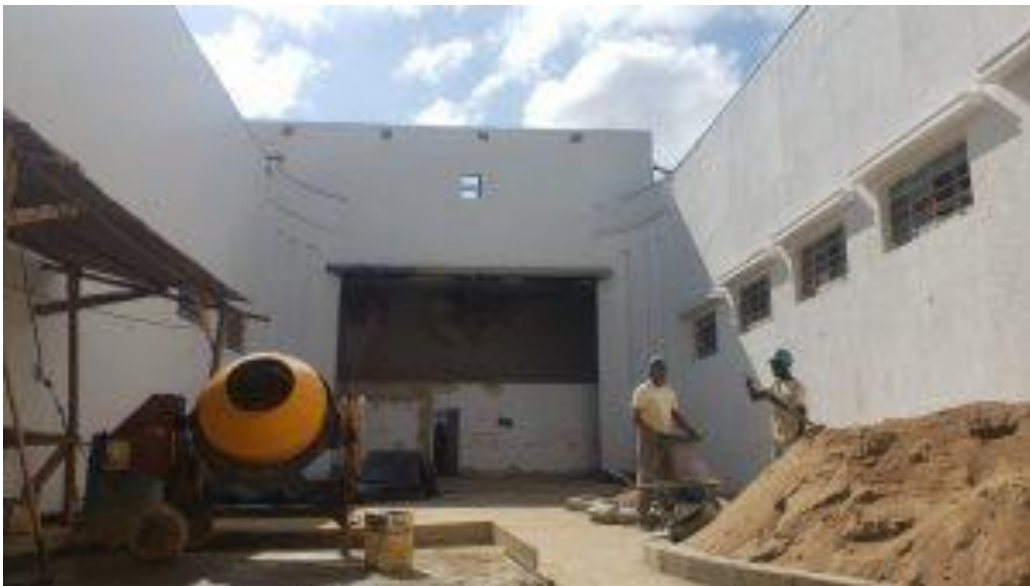
Figura 21 - Parte dos fundos do Cine Brasil com paredes originais.
