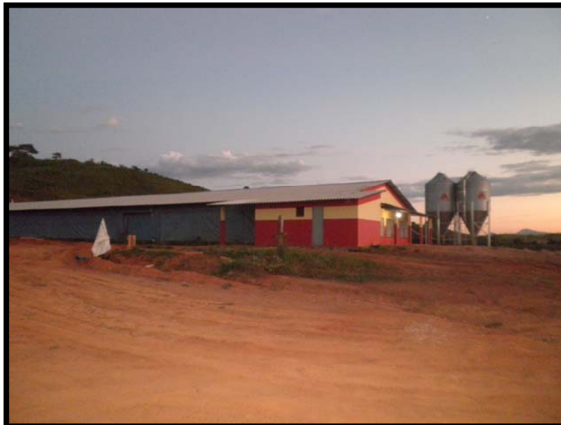
Ilustração 10- Lateral galpão climatizado (novo). Fonte: Dados da pesquisa, 2012.
