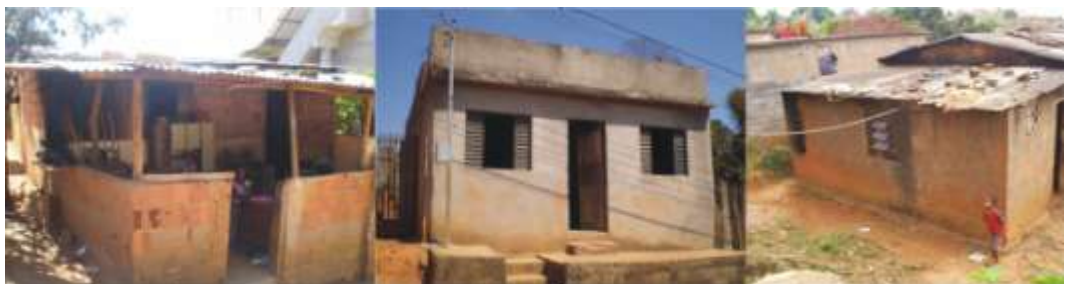
Figura 37 - Edificações no Bairro Nova Viçosa. Fonte: (SANTOS; CARVALHO; TRINDADE, 2011).
