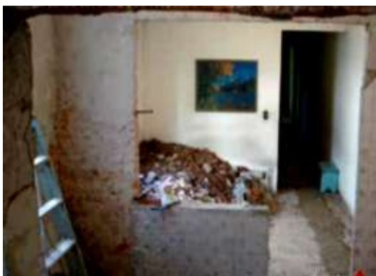
Figura 16 – O antes da reforma de uma moradia na Vila Brasilina, São Paulo/SP. Fonte: http://www.arquitetasdacomunidade.org.br/ , 2006.
