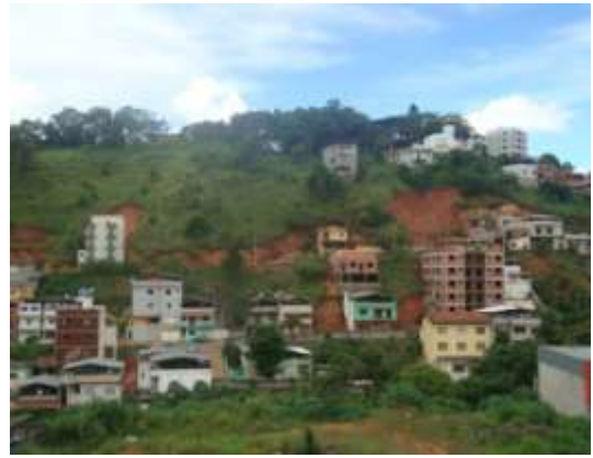
Figura 9 – O detalhe de uma das encostas ocupadas por edificações na cidade de Viçosa/MG.
