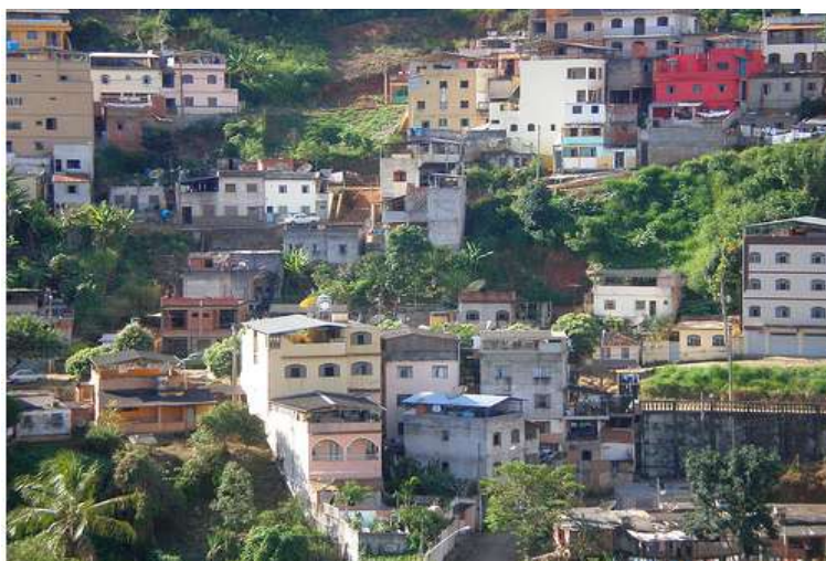
Figura 12 - Vista parcial do Morro do Café, uma ocupação irregular de moradias autoconstruídas em uma das encostas da cidade de Viçosa/MG. Fonte: http://www.google.com.br/ , 2011.
