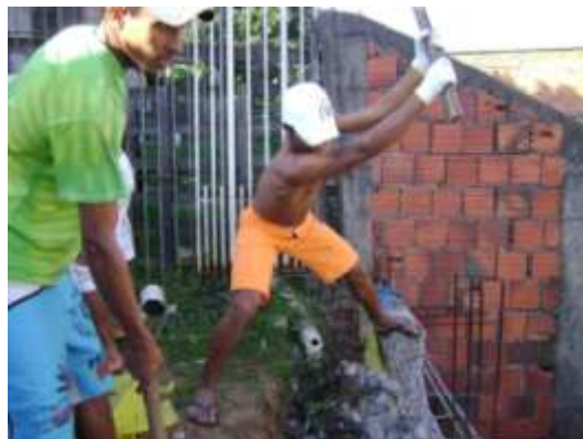
Figura 25 – Moradores da comunidade realizando a remoção do muro de arrimo. Fonte: Daniela Zacardi, 2008.
