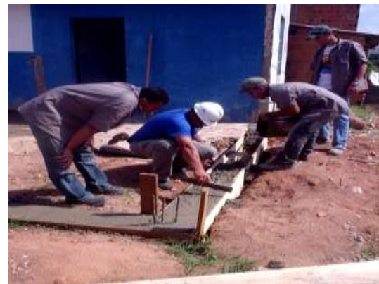
Figura 23 - Curso de pedreiros no Complexo Oziel, em Campinas/SP. Fonte: http://www.arquitetasdacomunidade.org.br/ , 2008.
