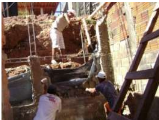
Figura 24 – Obra de remoção do muro de arrimo sob risco. Fonte: Daniela Zacardi, 2008.
