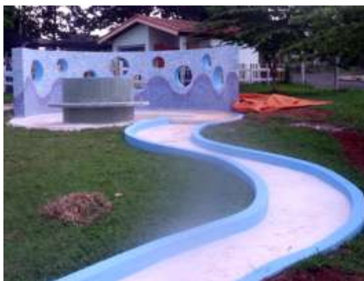
Figura 28 - Reforma em creche de Campinas. Espaço “Cantinho da Água”. Fonte: http://www.arquitetasdacomunidade.org.br/ , 2010.
