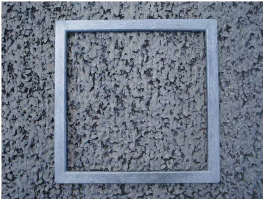
Figura 83 – Área altamente emborrachada
