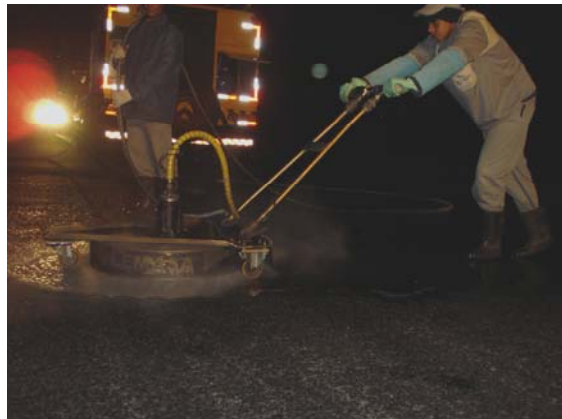
Figura 70 – Limpeza da pista equipamento de barra giratória
