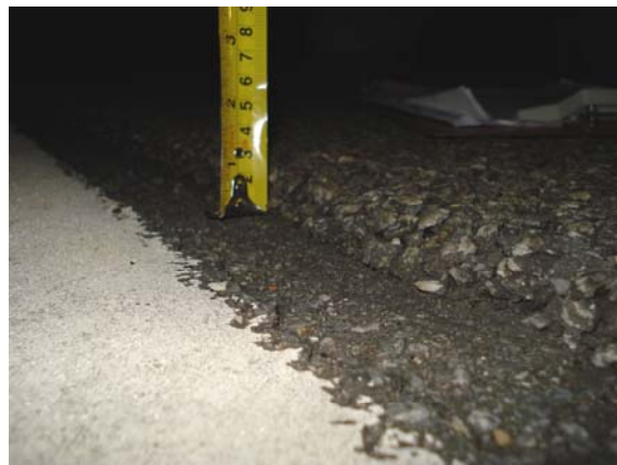
Figura 20 – Detalhe da espessura da CPA
