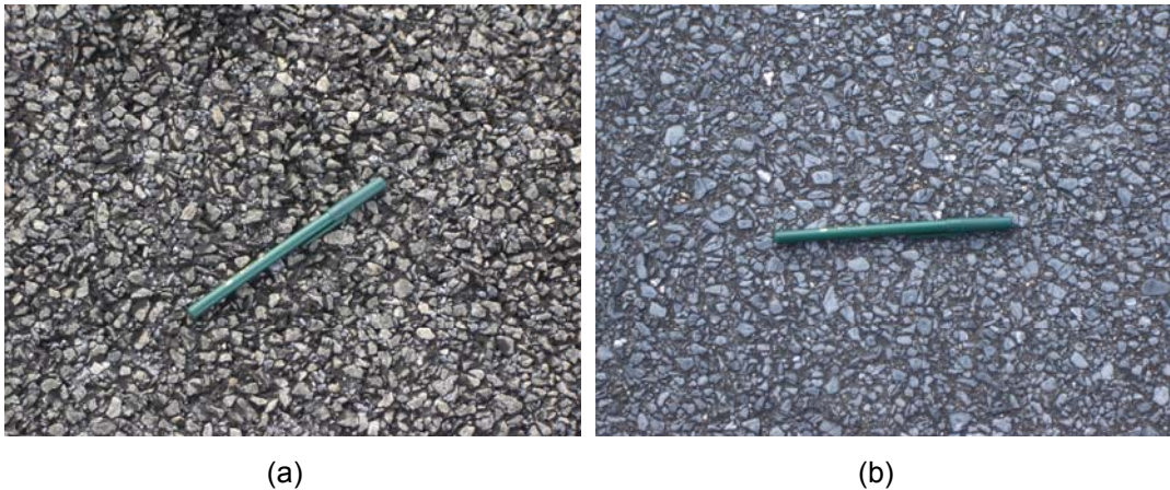
Figura 19 – Camada Porosa (a) e CBUQ Tradicional (b)
