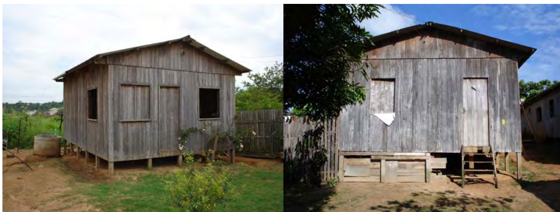
Figuras 27: Casas de Madeira sobre Palafita (Fotos do autor, 11/2004)
