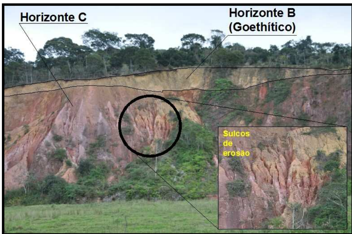
Figura 36. Perfil de solo expondo o horizonte “C” profundo, na Unidade Geológica Granitóide Silveirânia. Chama-se a atenção para o contraste entre o horizonte B e C de forma abrupta o que pode induzir a um depósito. Observa-se também a erosão em sulcos mais pronunciada no horizonte “C”.
