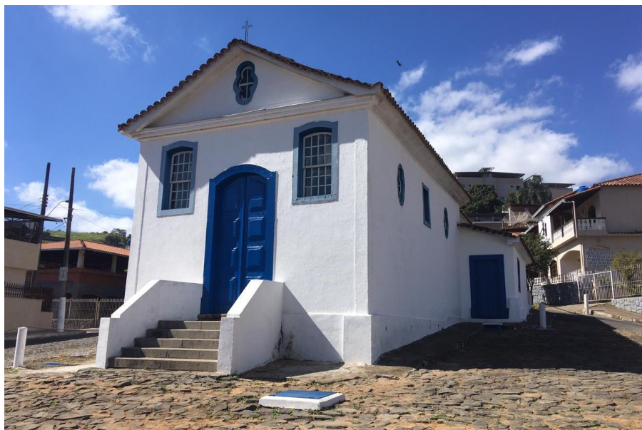
Figura 27 – Capela da Fazenda de Nossa Senhora da Conceição do Registro do Caminho Novo, Matias Barbosa
