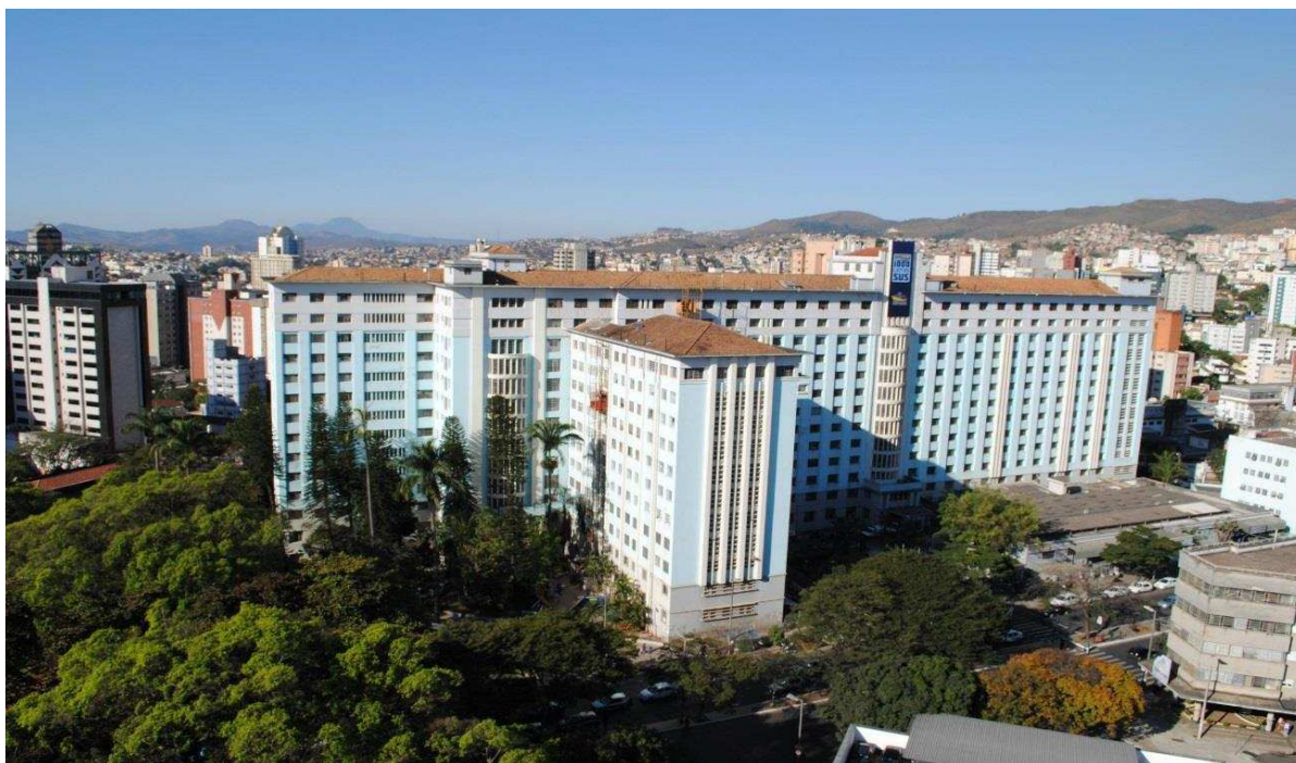
Figura 1 – Hospital Santa Casa de Misericórdia de Belo Horizonte
