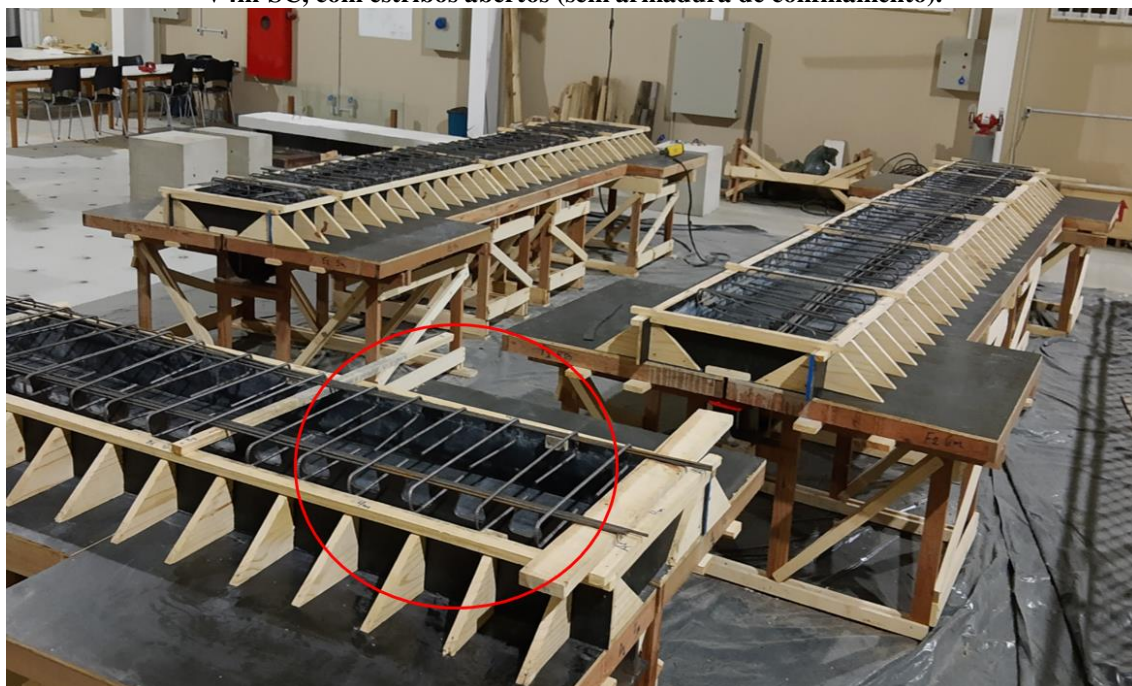
Figura 46. Operação de montagem das armaduras para a segunda concretagem, com destaque para a viga V4m-SC, com estribos abertos (sem armadura de confinamento).
