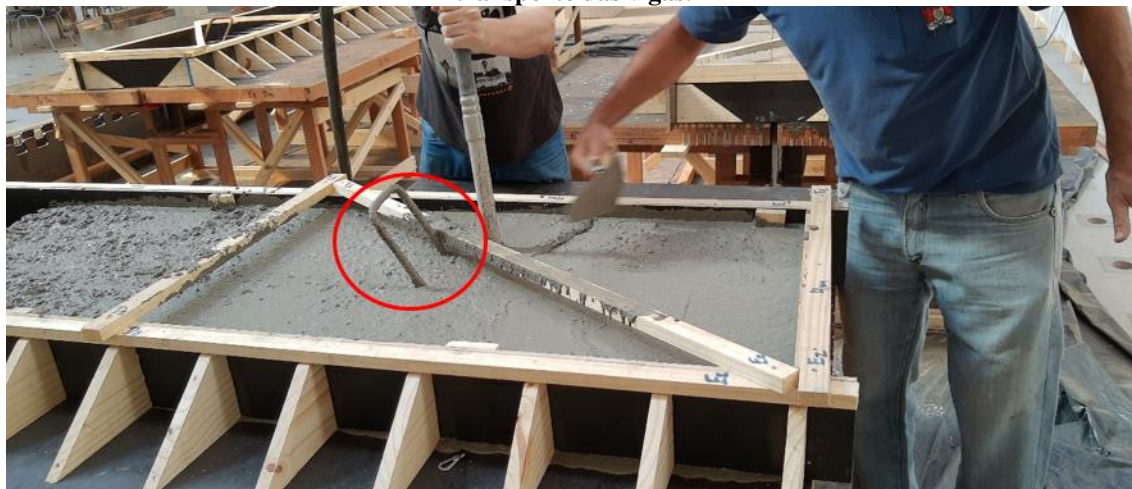
Figura 48. Lançamento do concreto sobre as fôrmas e seu adensamento: em destaque o gancho para transporte das vigas.
