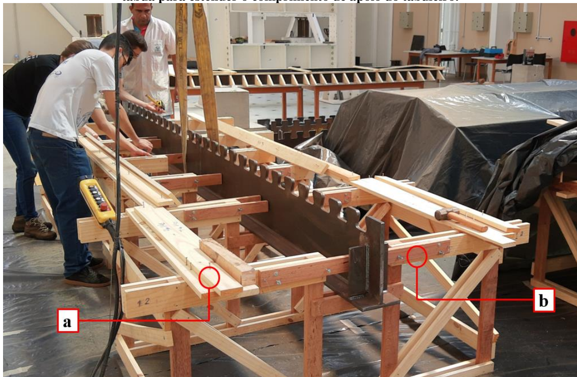
Figura 41. Posicionamento do perfil no sistema de sustentação das fôrmas. Detalhes: (a) tábuas longitudinais para solidarizar os quadros de suporte em sua posição correta e apoiar o tabuleiro; (b) tábua para estender o comprimento de apoio do tabuleiro.
