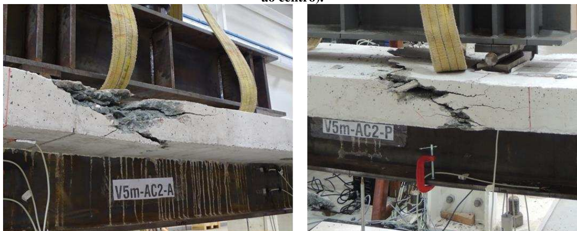
Figura 97. Detalhes da falha da viga V5m-AC2: face anterior (superior à esq.); face posterior (superior à dir.); e vista superior da região de falha, com destaque para a existência de fissuras horizontais (inferior ao centro).
