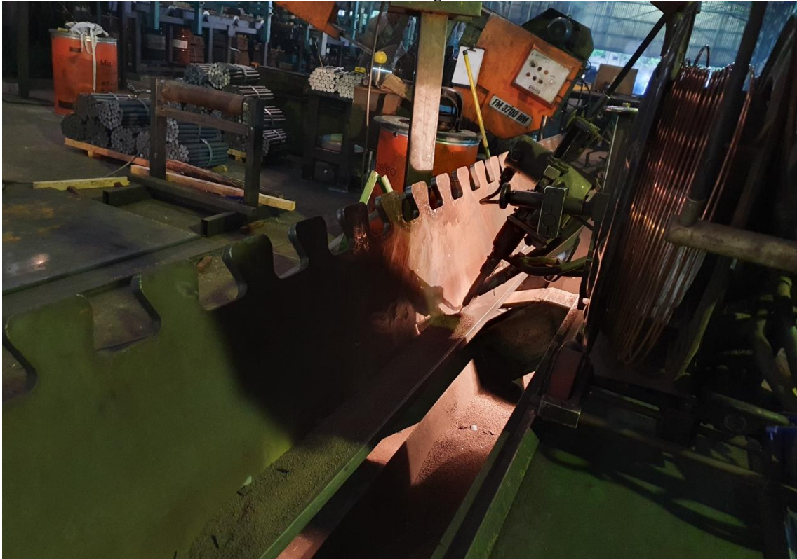
Figura 37. Operação de soldagem por arco submerso (SAW) para fabricação dos perfis de aço constituintes das vigas mistas.
