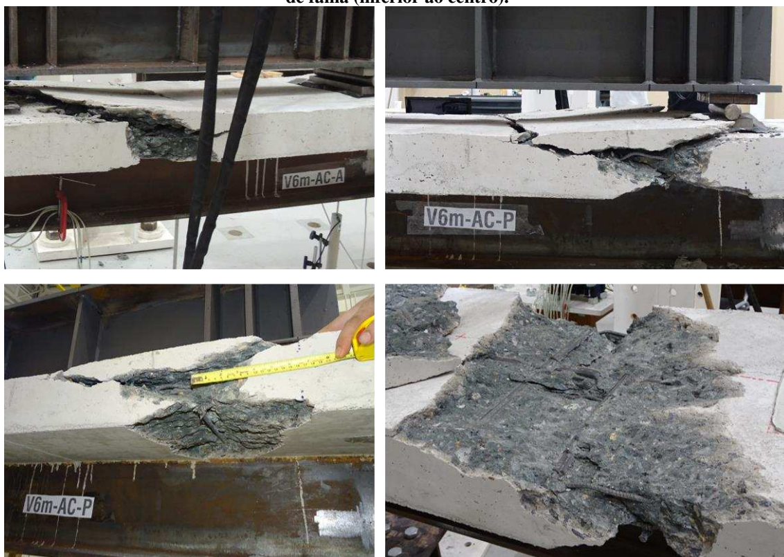
Figura 110. Detalhes da falha da viga V6m-AC: face anterior (superior à esq.); face posterior (superior à dir.); detalhe da região inferior da laje na face posterior da viga (inferior à esq.); e vista superior da região de falha (inferior ao centro).
