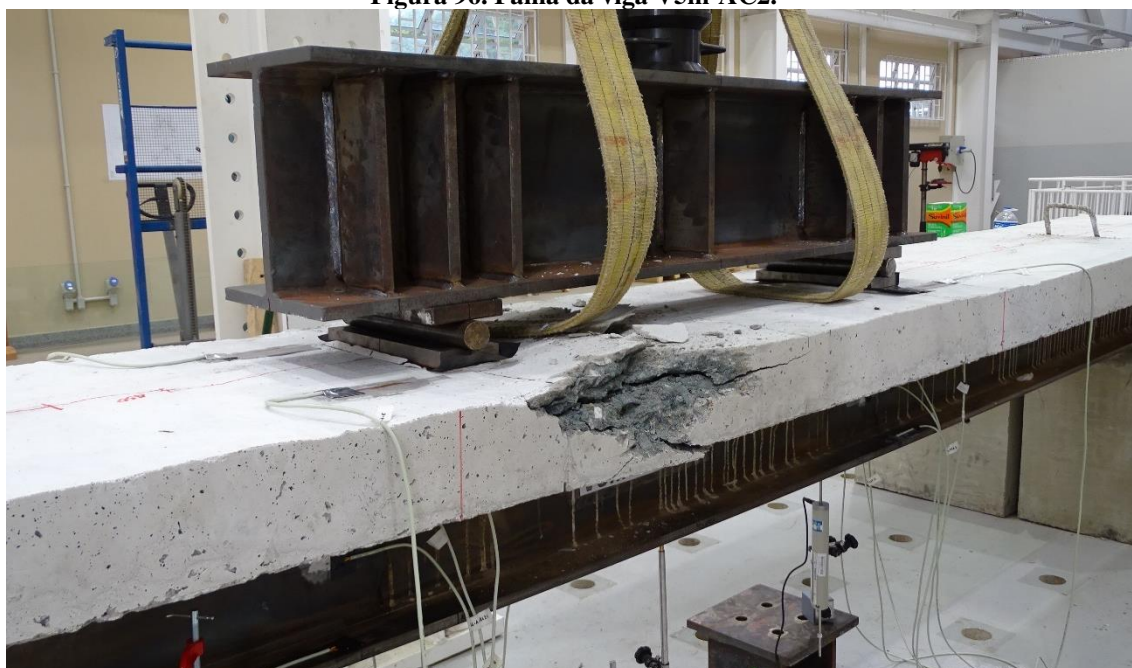
Figura 96. Falha da viga V5m-AC2.
