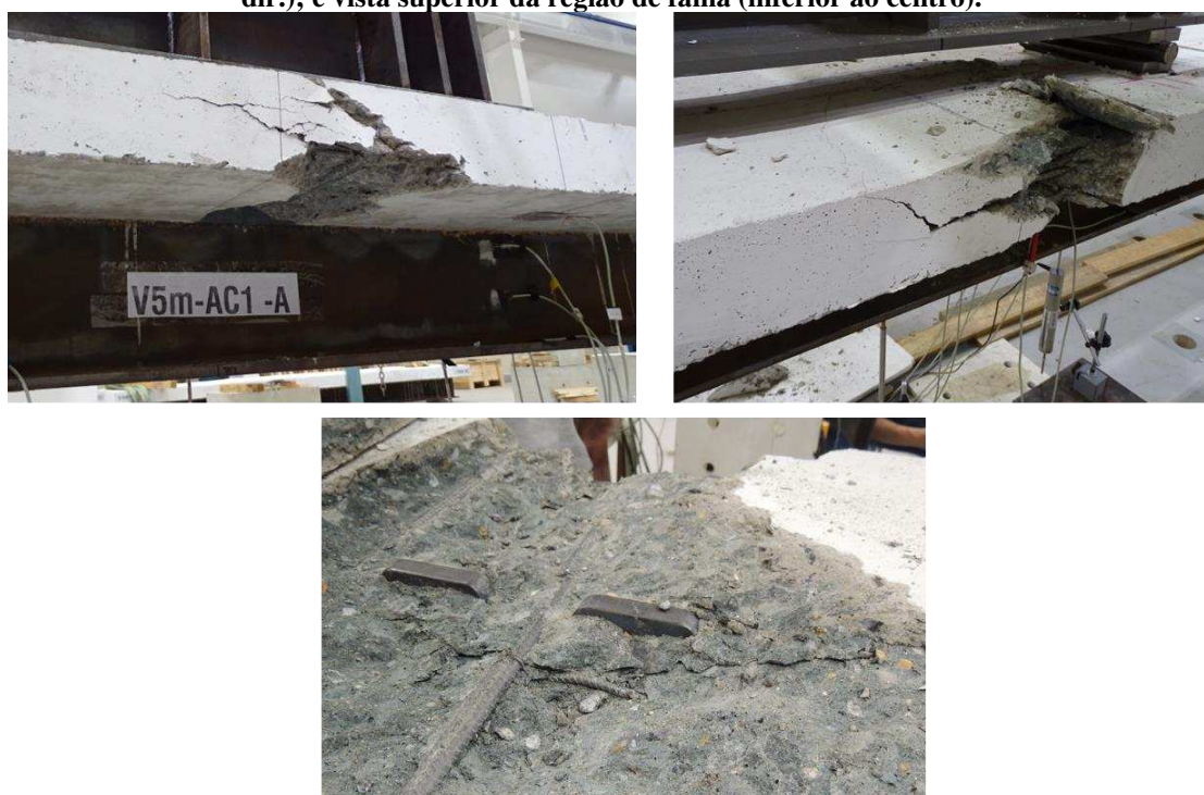
Figura 88. Detalhes da falha da viga V5m-AC1: face anterior (superior à esq.); face posterior (superior à dir.); e vista superior da região de falha (inferior ao centro).
