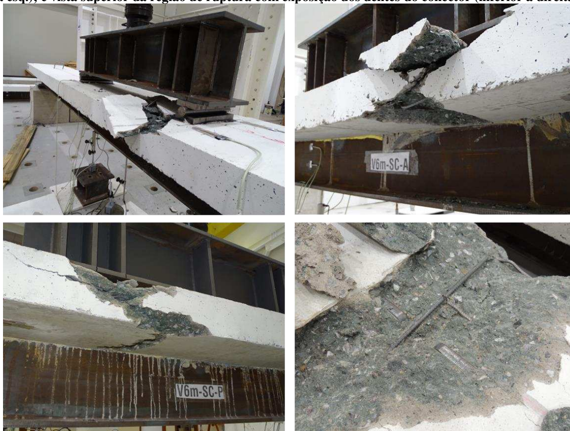
Figura 119. Falha da viga V6m-SC: aspecto geral da viga após a ruptura (superior à esq.); detalhe da seção de ruptura na face anterior (superior à dir.); detalhe da seção de ruptura na face posterior (inferior à esq.); e vista superior da região de ruptura com exposição dos dentes do conector (inferior à direita).
