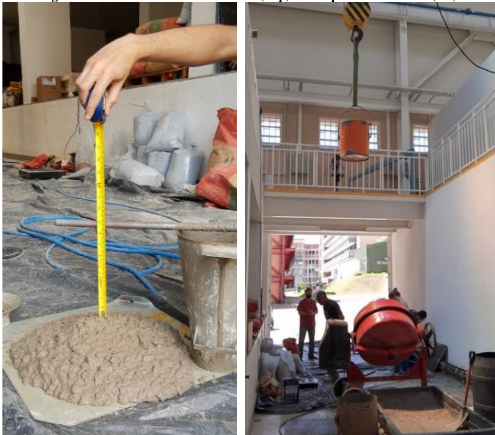
Figura 47. Teste de abatimento de cone (esq.) e transporte do concreto (dir).
