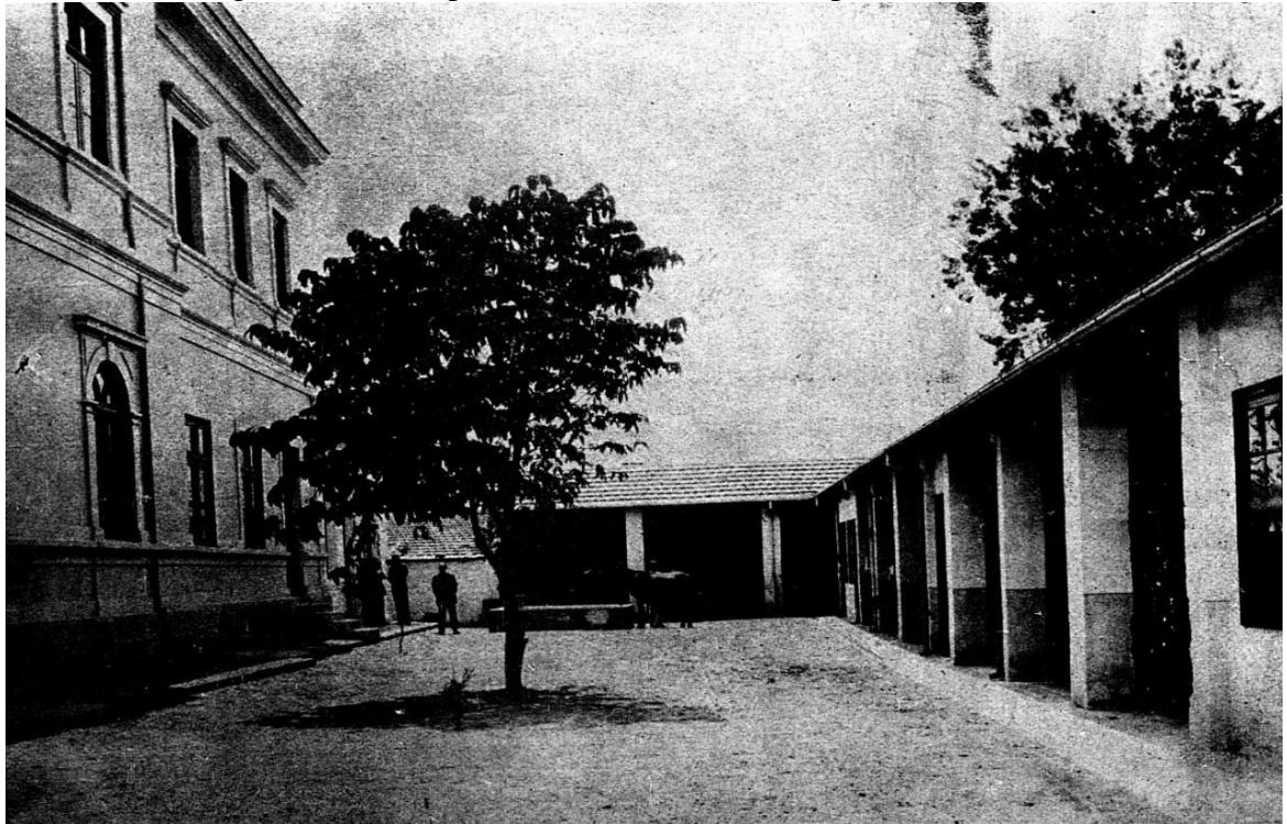
Figura 11 – Face posterior da Secretaria e depósito de veículos
