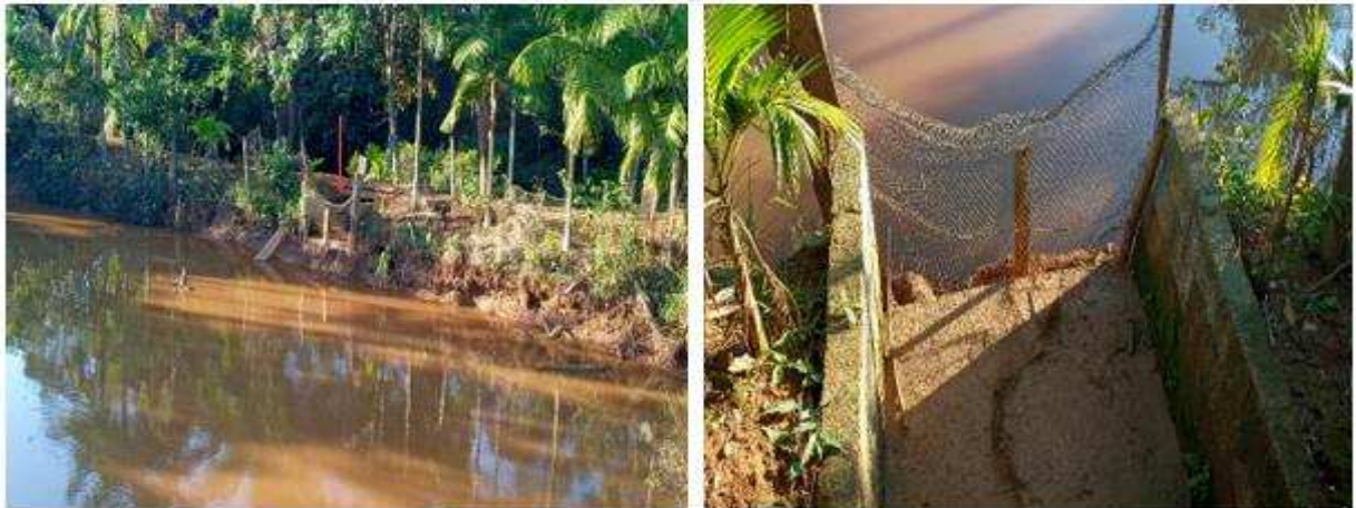
Figura 5. Vertedor retangular dimensionado em um pequeno reservatório de terra, localizado em uma microbacia hidrográfica na comunidade Fartura no município de São Miguel do Anta, Minas Gerais, Brasil. Fonte: Próprio autor.
