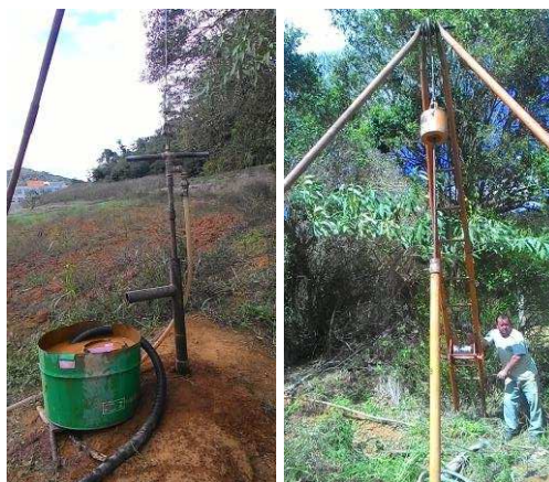
Figura (I) 7: Realização a sondagem à percussão para os dois novos furos.
