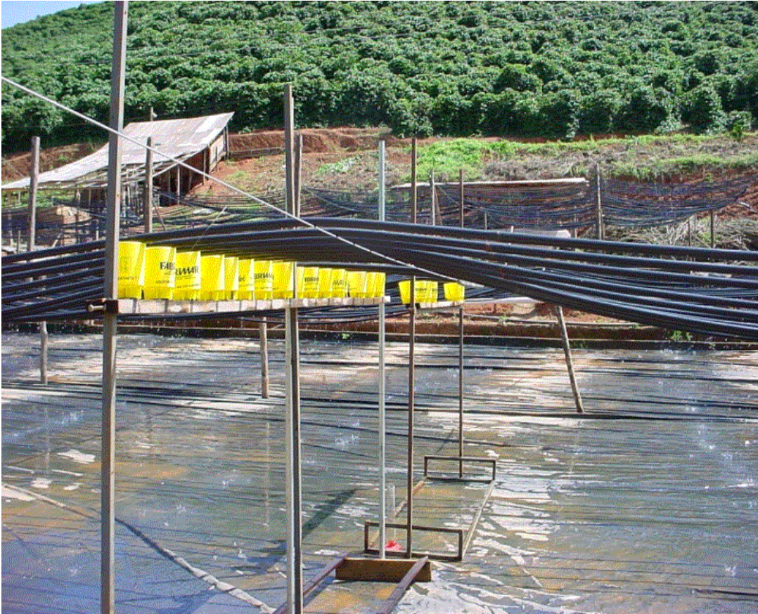
Figura 3 – Avaliação do sistema de irrigação
