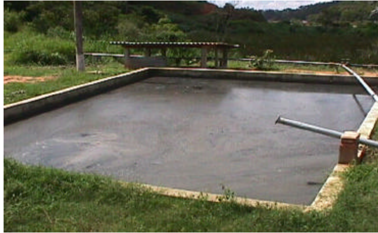
Figura 4 - Vista do reservatório de captação e à direita, uma tubulação de recirculação da água residuária.
