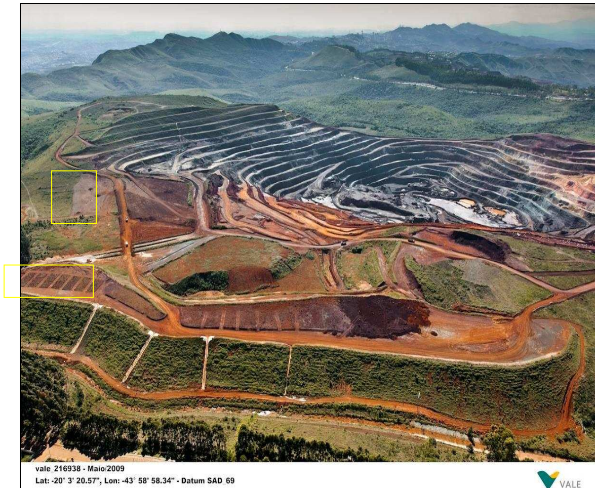
Figura 1. Imagem aérea da mina de Capão Xavier indicando a área de montagem do experimento e a área de empréstimo do topsoil .
