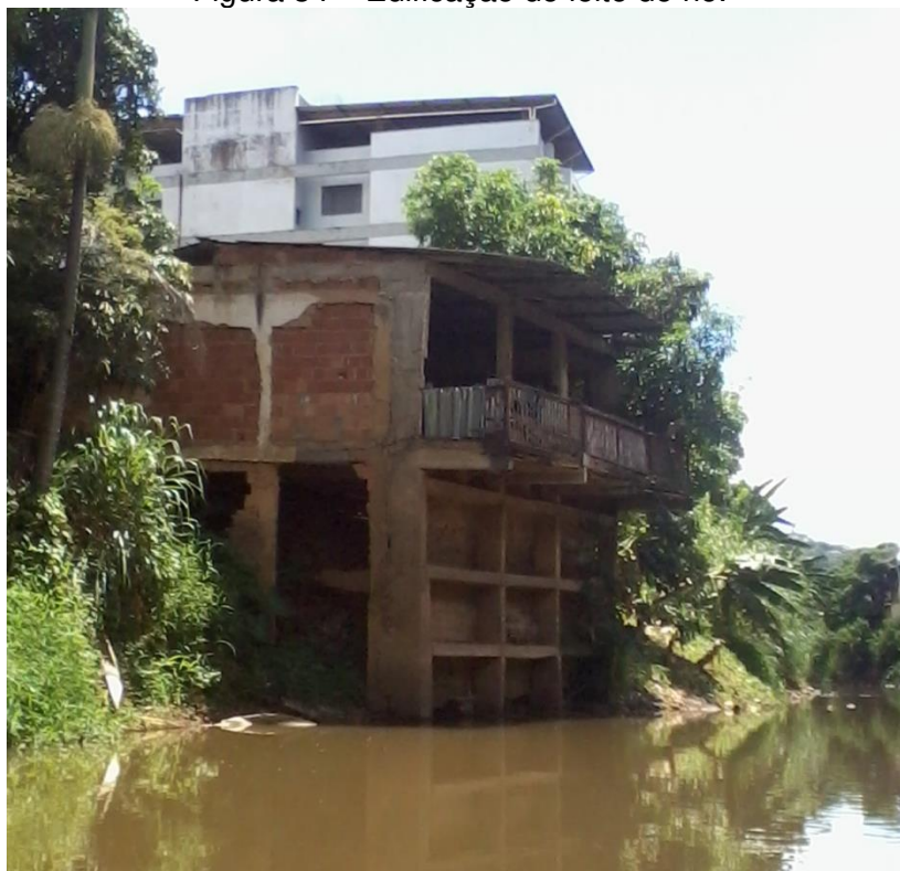
Figura 34 – Edificação do leito do rio.
