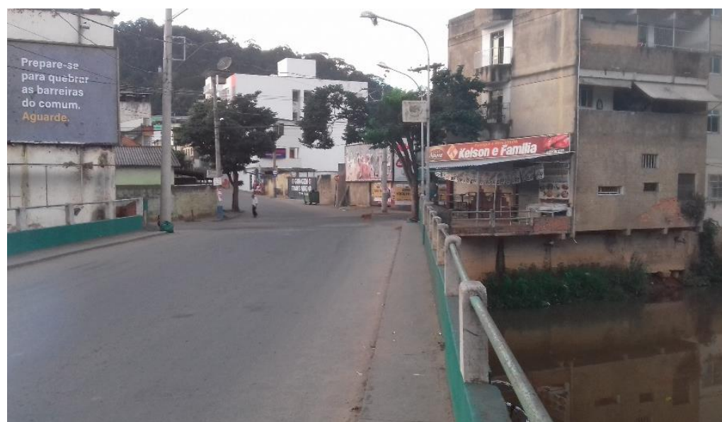
Figura 24 – Ponte sobre o Rio Manhuaçu.
