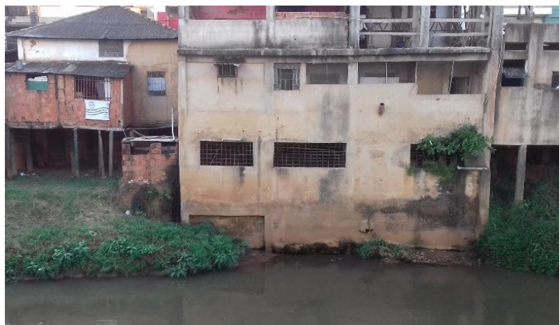
Figura 33 – Edificações na faixa de preservação do rio.
