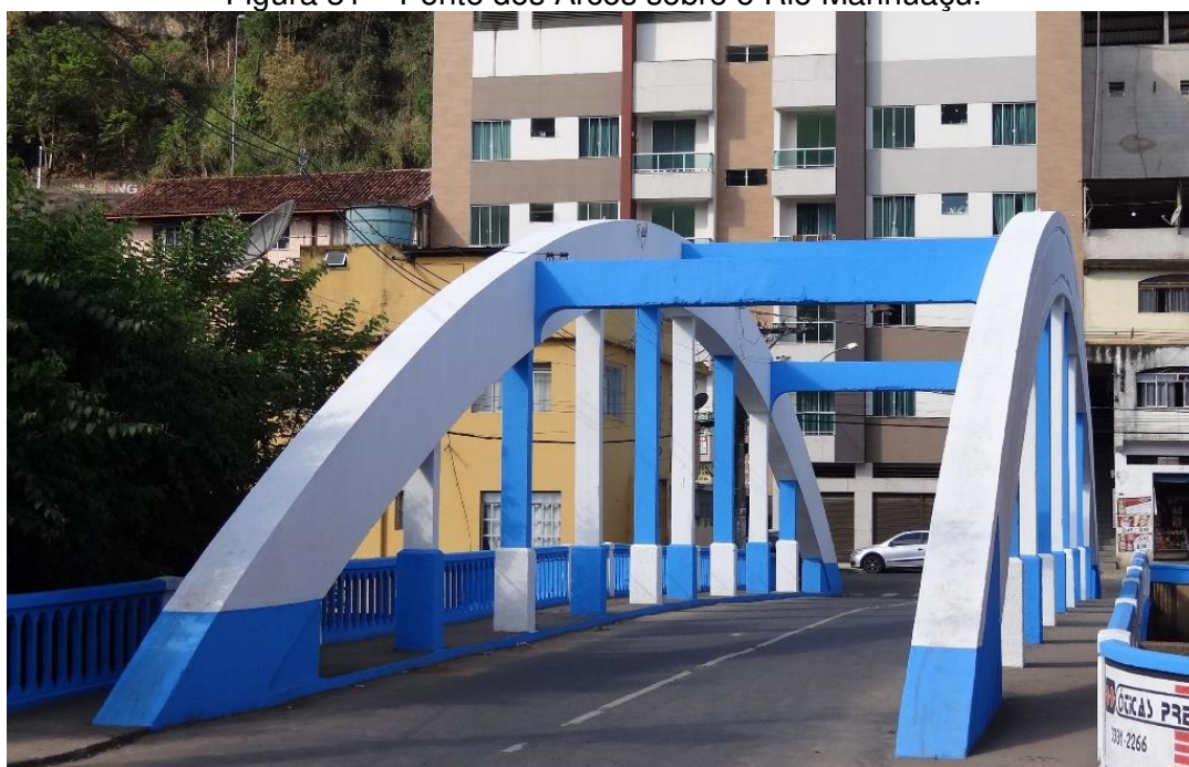
Figura 31 – Ponte dos Arcos sobre o Rio Manhuaçu.
