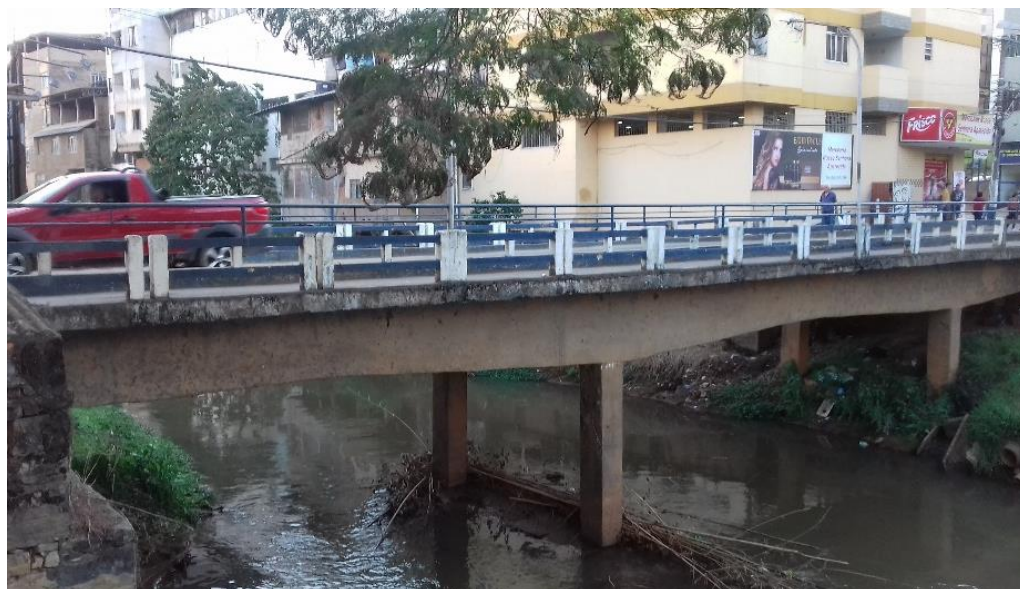
Figura 23 – Ponte sobre o Rio Manhuaçu.
