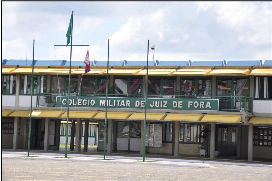
Figura 1 – Fachada do Colégio Militar de Juiz de Fora.
