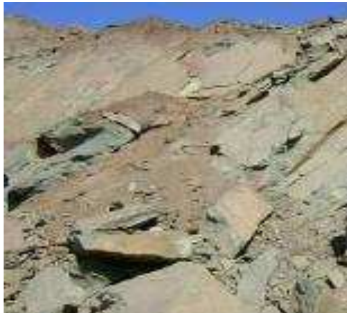
Figura 22– Talude composto de básicas intrusivas (VALE, 2008)
