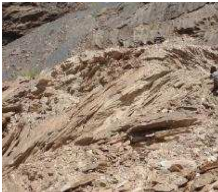
Figura 23 – Talude composto de rochas metavulcânicas alteradas (VALE, 2008)
