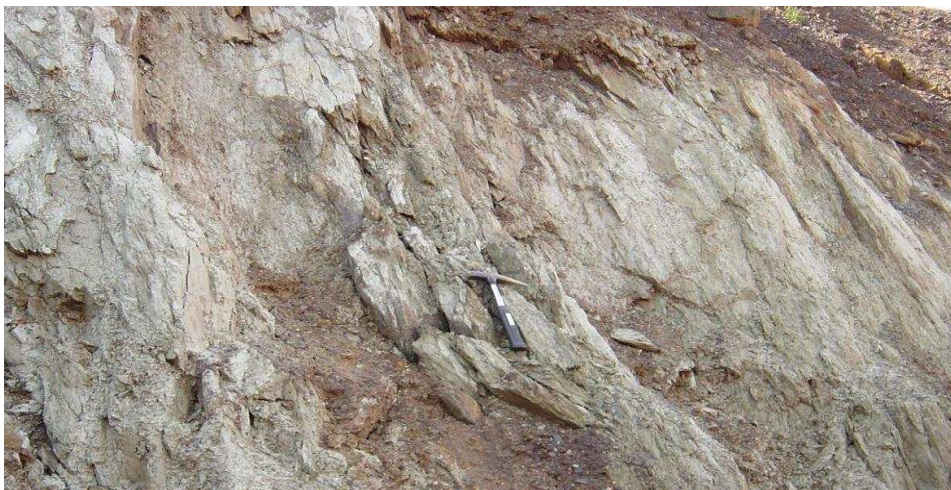
Figura 13 – Talude em filito sericítico (OURO PRETO GEOLOGIA E PESQUISA MINERAL, 2004)
