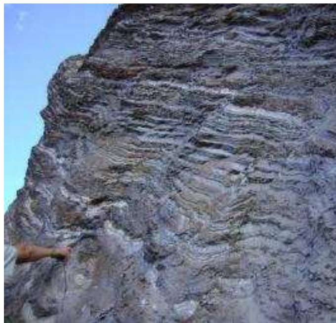
Figura 17 – Talude em itabiritos friáveis silicosos - IFS. (VALE, 2008)
