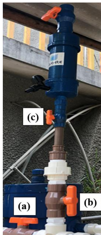
Figura 11 - Dosador de cloro da Salta-z.
