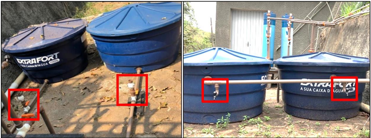
Figura 9 - Tanques de contato, com indicação dos pontos de conexão do dosador de cloro (A) e dos pontos de coleta de água clorada (B).
