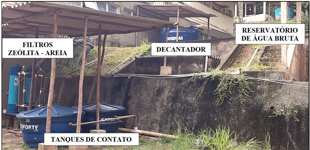
Figura 6 - Configuração das unidades da Salta-z instaladas nas dependências da DAG-UFV.
