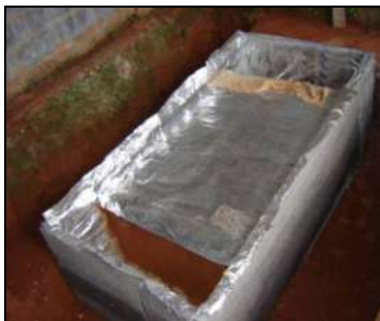
Figura 3.26 – Vista do lisímetro sem as fôrmas.
