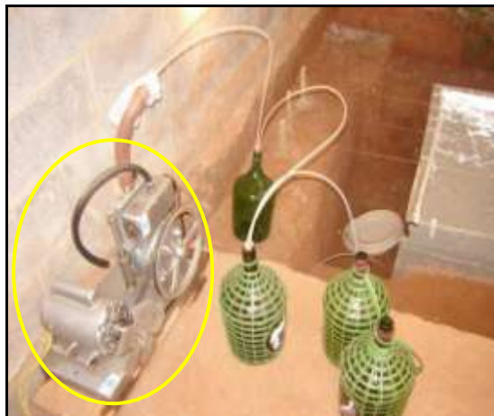
Figura 3.30 – Bomba a vácuo utilizada na retirada de efluente.
