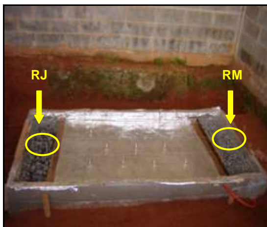
Figura 3.44 – Tubos de monitoramento instalados nos reservatórios.
