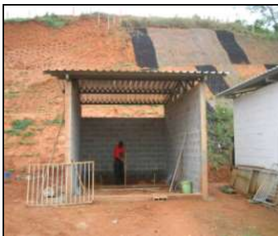
Figura 3.16– Área coberta para escavação do lisímetro.
