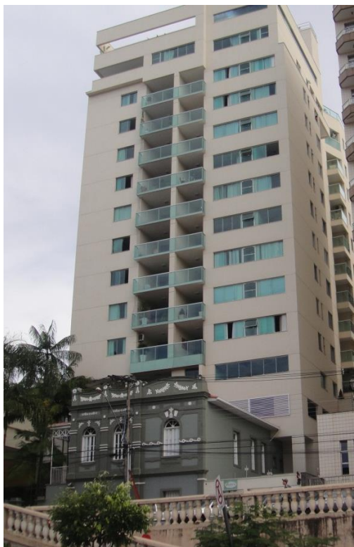
Figura 30 – Residência histórica preservada na Av. Bueno Brandão, n. 54, com o edifício aos fundos. Fonte: Paula (2011).
