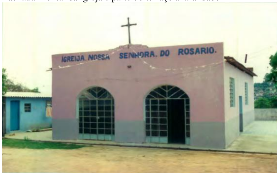
Figura 17 - Fachada Frontal da Igreja e parte do terraço avarandado
