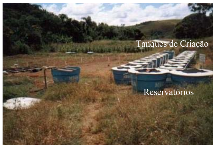
Figura 9 - Reservatórios e tanques de criação de peixes, Unidade Integrada de Tratamento de Esgotos e Utilização de Efluentes da Violeira (Viçosa, MG).
