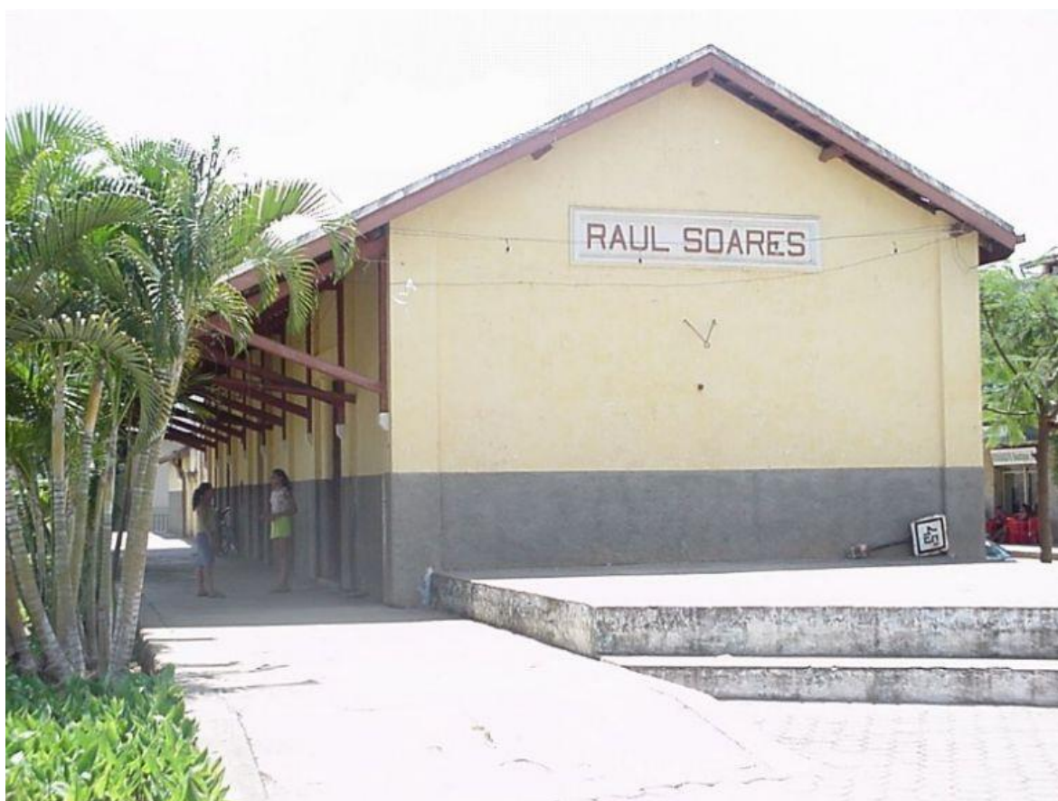
Figura 60. Fonte: http://www.estacoesferroviarias.com.br/efl_mg_tresrios_caratinga/raulsoares.htm , acessado em 21 jan. 2020.
