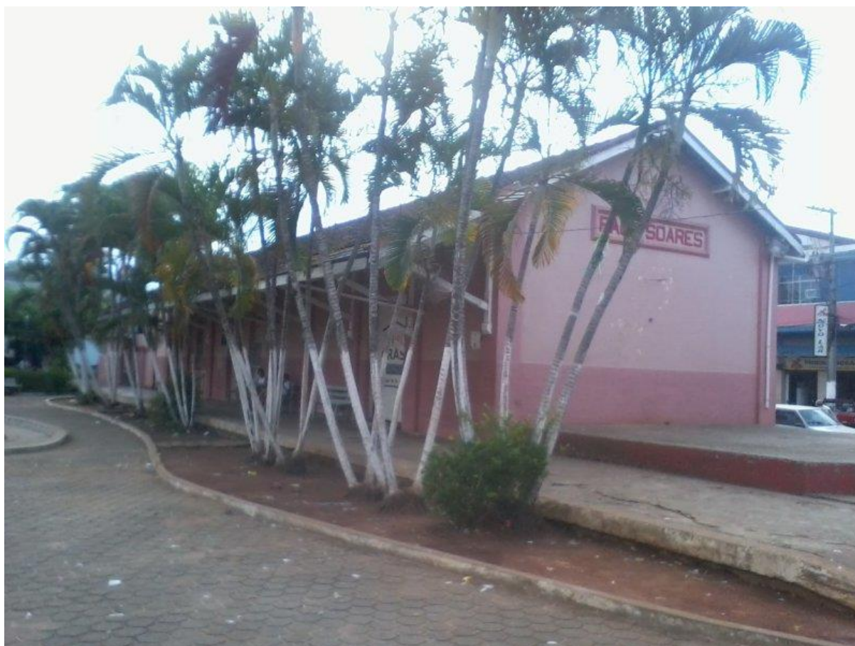
Figura 59. Fonte: http://www.estacoesferroviarias.com.br/efl_mg_tresrios_caratinga/raulsoares.htm , acessado em 21 jan. 2020.
