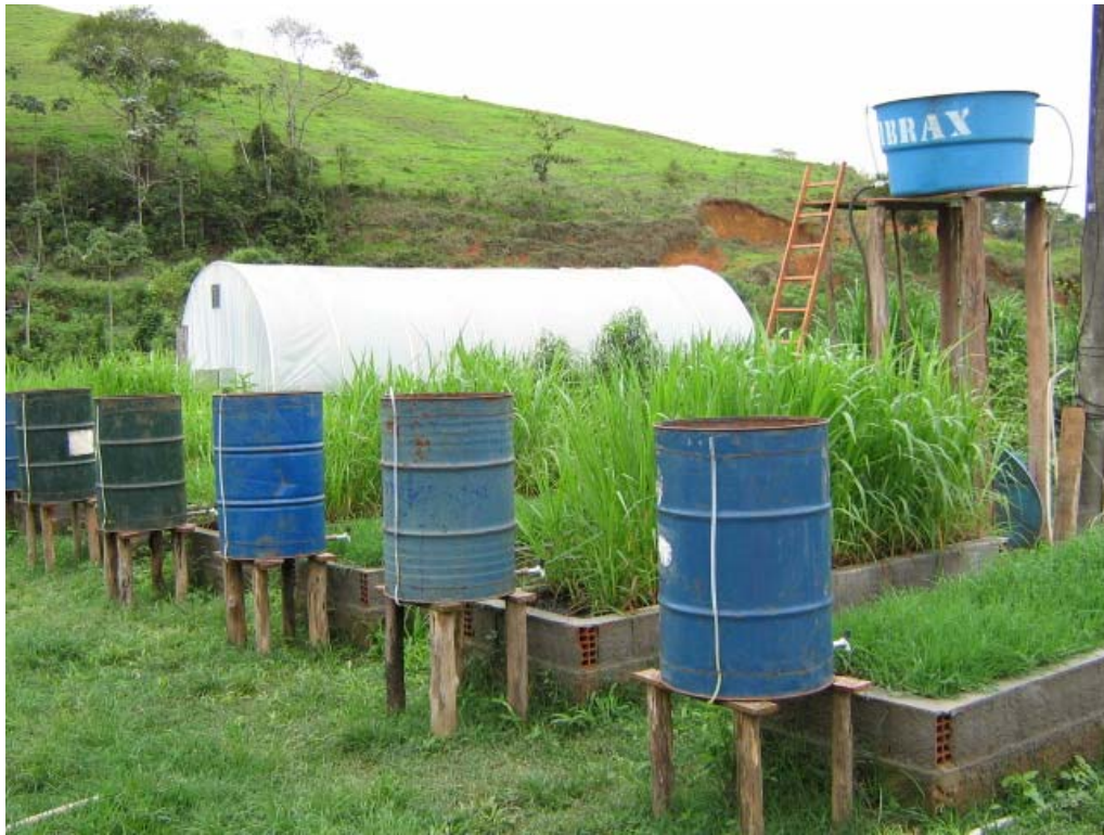
Figura 1: Vista geral do sistema de distribuição da ARL na zona de entrada dos SACs.
