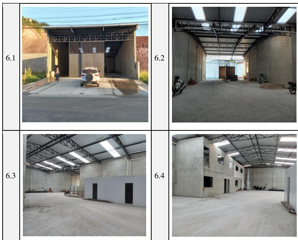
Imagem 6: Prédio da nova sede da COOPAF, em reforma para adequação estrutural.
