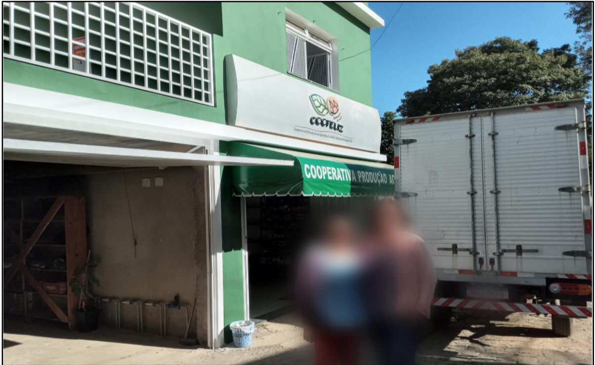
Imagem 2: Fachada da COOFELIZ, prédio do SINTRAF.
