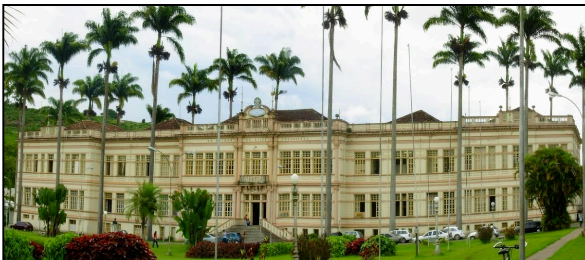
Figura 4 - Edifício Arthur Bernardes - UFV.
