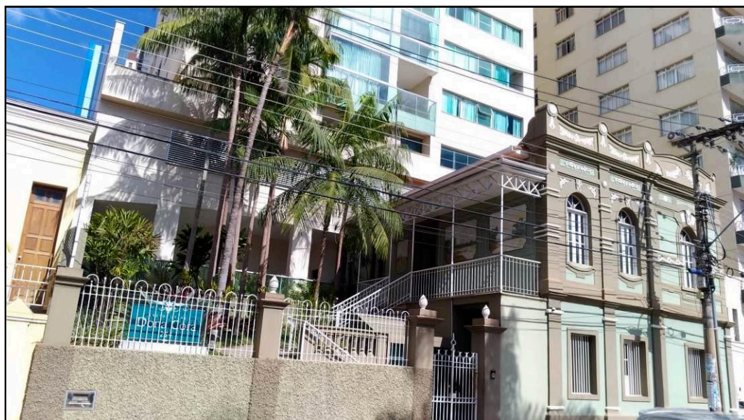
Figura 15: Casa “Cora Bolívar” na Avenida Bueno Brandão, centro- Viçosa (MG). Destaque para o edifício construído nos fundos da edificação.
