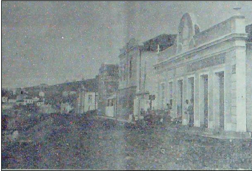
Figura 3 – Avenida Bueno Brandão em construção, Viçosa (MG) – 1910.
