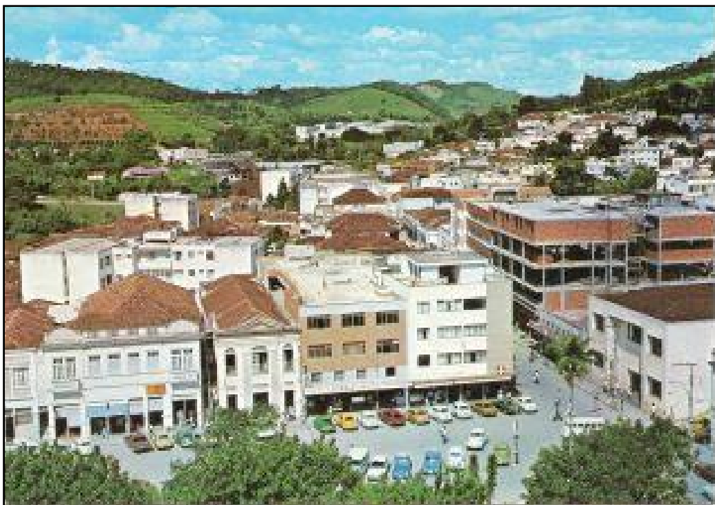
Figura 14 – Vista parcial do centro de Viçosa, década de 1980, destacando as novas construções.
