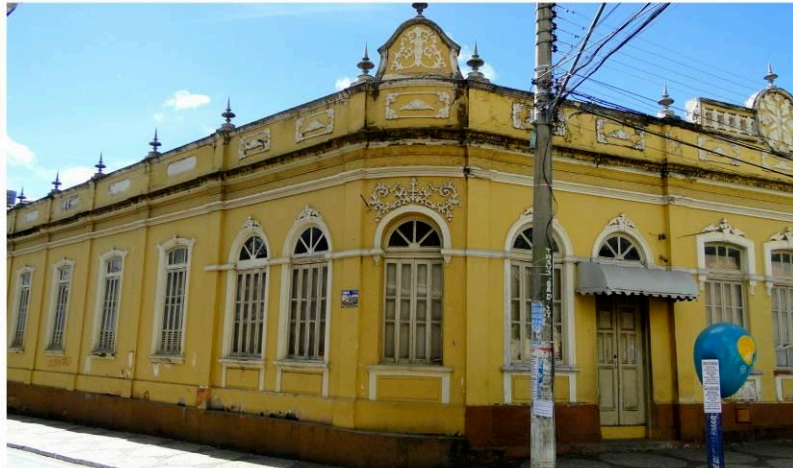
Fig. 36 O Hotel Rubim é uma imponente construção eclética do início do século XX, porém sem registro de tombamento. O imóvel faz parte dos bens inventariados de Viçosa-MG e está dentro das áreas de proteção da Casa Arthur Bernardes, da Estação Cultural Hervé Cordovil e do Balaústre.
