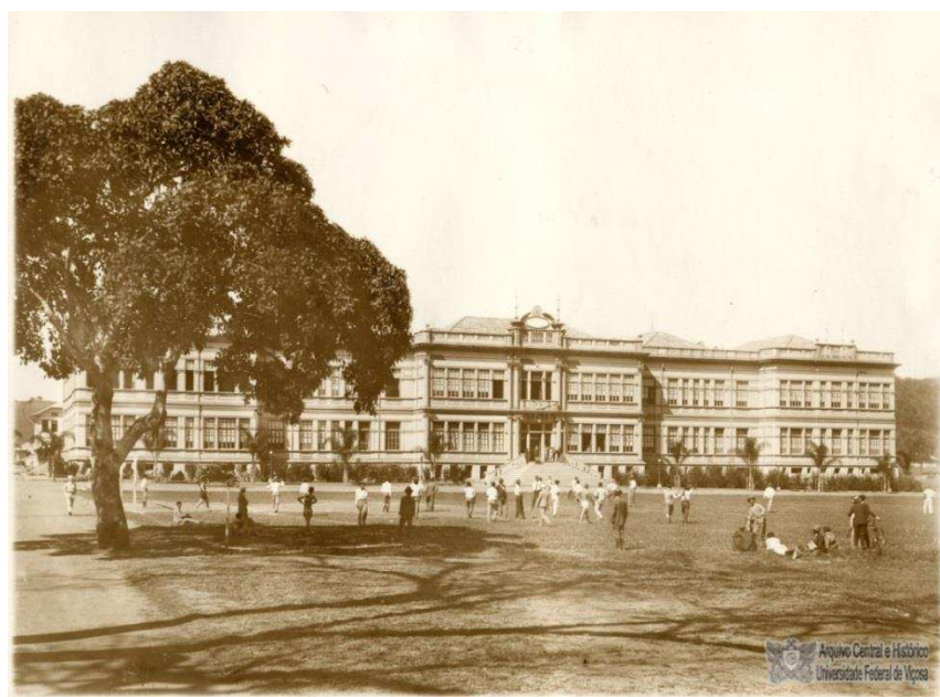
Paineira e Prédio Principal, década de 1930
