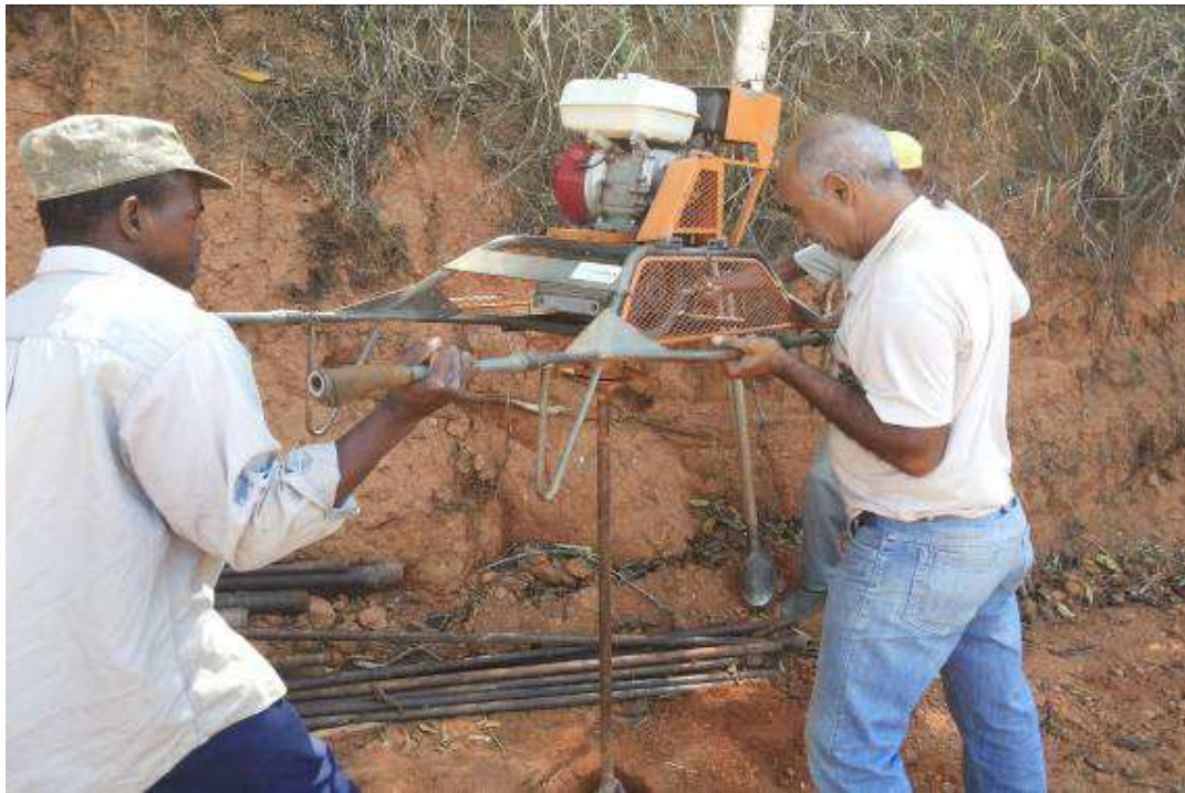
Figura 3.4 – Perfuração das estacas com auxílio de trado mecanizado.
