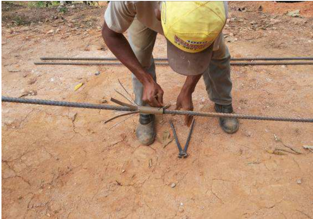
Figura 3.5 – Fixação do espaçador
