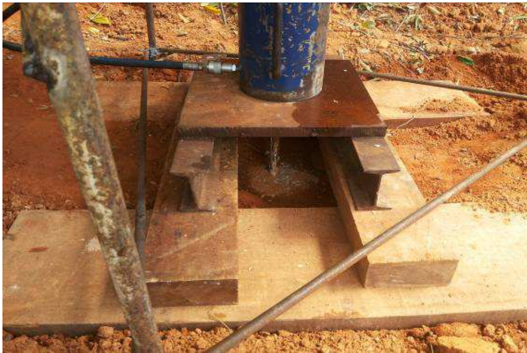
Figura 3.10 – Montagem da base de apoio para o macaco hidráulico
