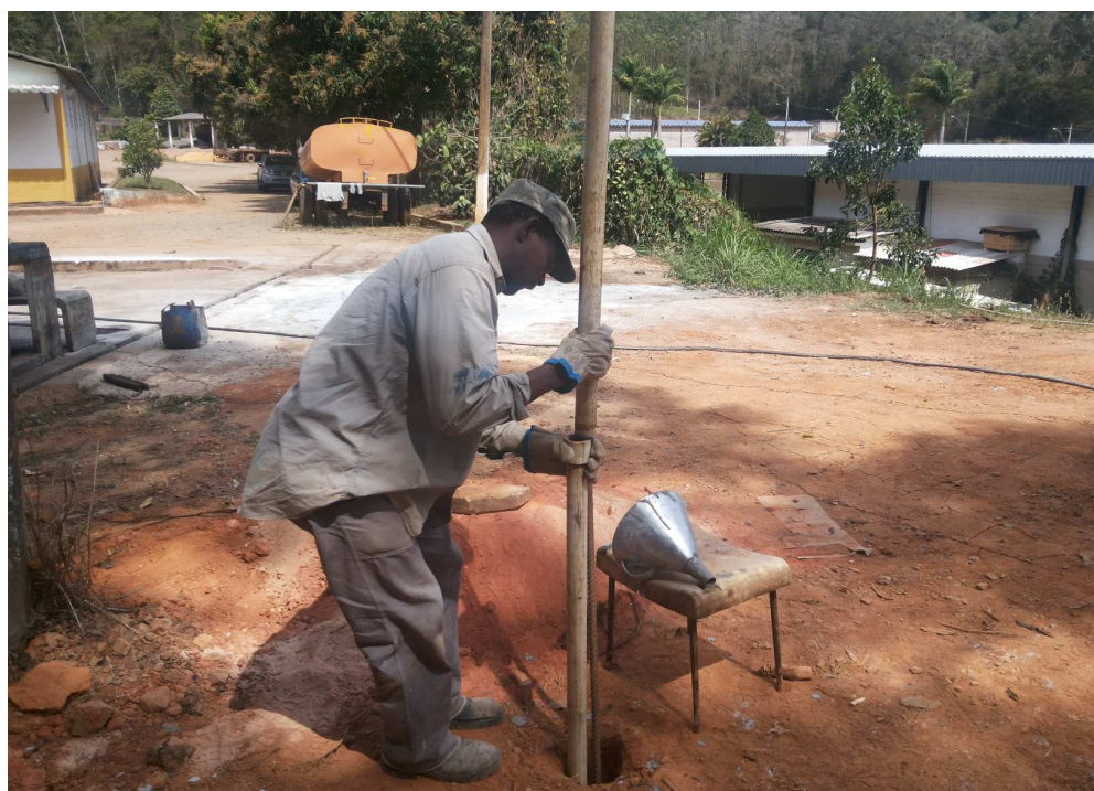
Figura 3.7 – Lançamento da pasta de cimento
