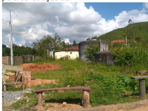
Figura 14 - Bairro Nova Diogo: obra iniciada para construção da ETA
