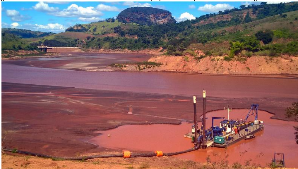
Figura 20 - Usina Hidrelétrica Risoleta Neves, após o rompimento da Barragem de Fundão
