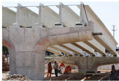
Figura 1: Vigas da estrutura de um viaduto em construção ( fonte: http://www.mtnacopa.com.br/download.php?id=222009 )
