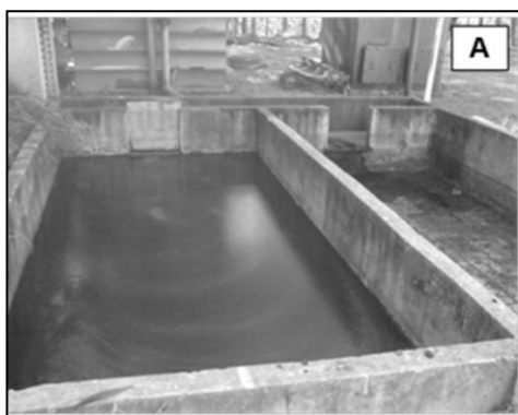
Figura 1.6 - Unidade Integrada de Tratamento e Utilização de Esgotos Sanitários da Violeira, Viçosa – MG. (A) Lodo imediatamente após o descarte do reator UASB nos leitos de secagem. (B) Lotes de lodo em diferentes estágios de tratamento na estufa.
