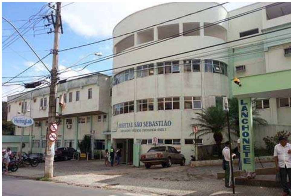
Figura 12 – Entrada do Hospital São Sebastião, em Viçosa-MG
