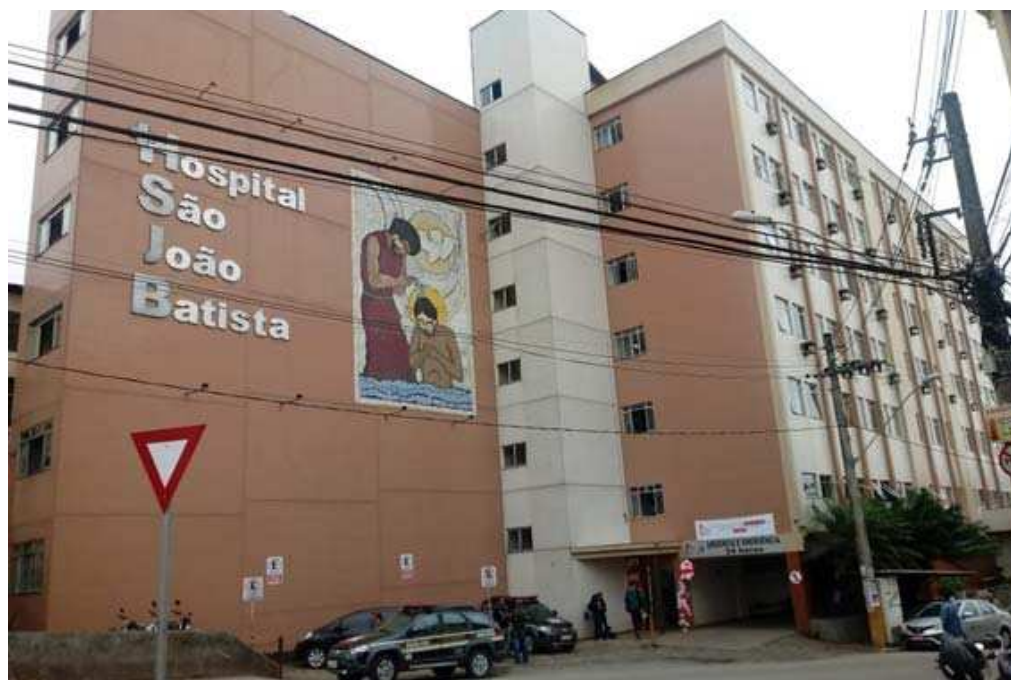
Figura 13 – Hospital São João Batista, em Viçosa MG
