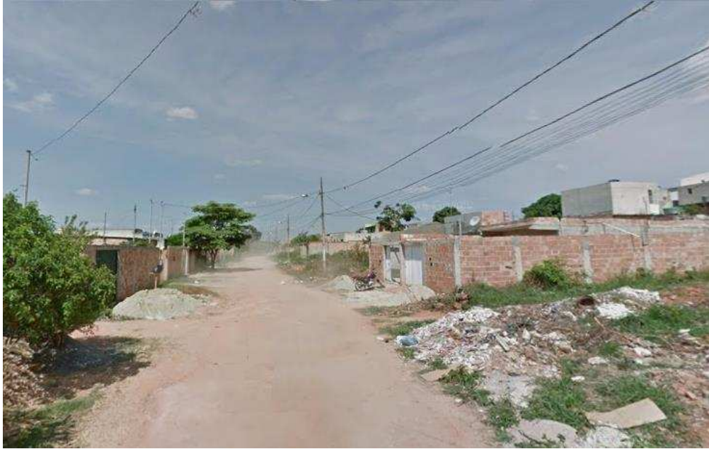
FIGURA 11 – Vista da Rua Sete, Santa Paula, Sede. Aprovado em 1986. Observa-se na figura o acúmulo de lixo e ausência de pavimentação e drenagem pluvial. Fonte: Arquivo Pessoal, 2015
