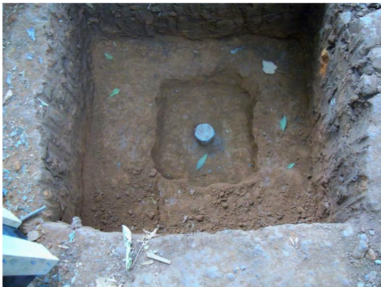
Figura 36 – Detalhes da prova de carga 04 com uma estaca e sem sapata.
