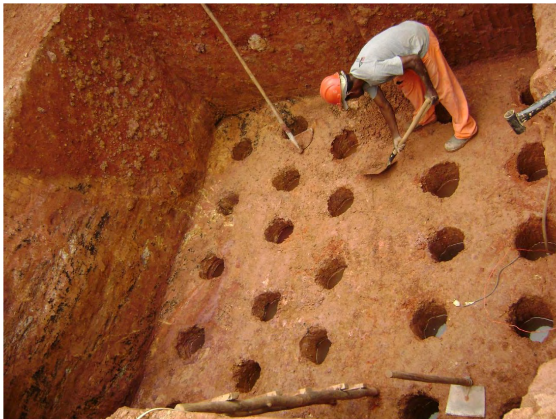
Figura 13– Escavação da cova da sapata com as estacas
