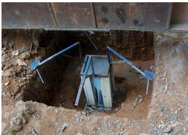
Figura 37 – Detalhes do bloco sobre a estaca da Prova de carga 04.
