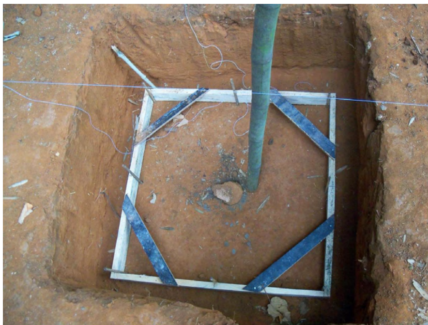
Figura 32 – Detalhes da prova de carga 02 com uma estaca broca.
