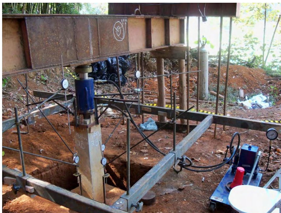
Figura 35 – Execução da prova de carga 03 com quatro estacas.
