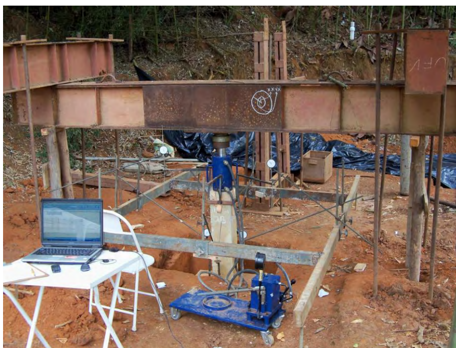
Figura 33 - Aplicação de carga na prova de carga 02.
