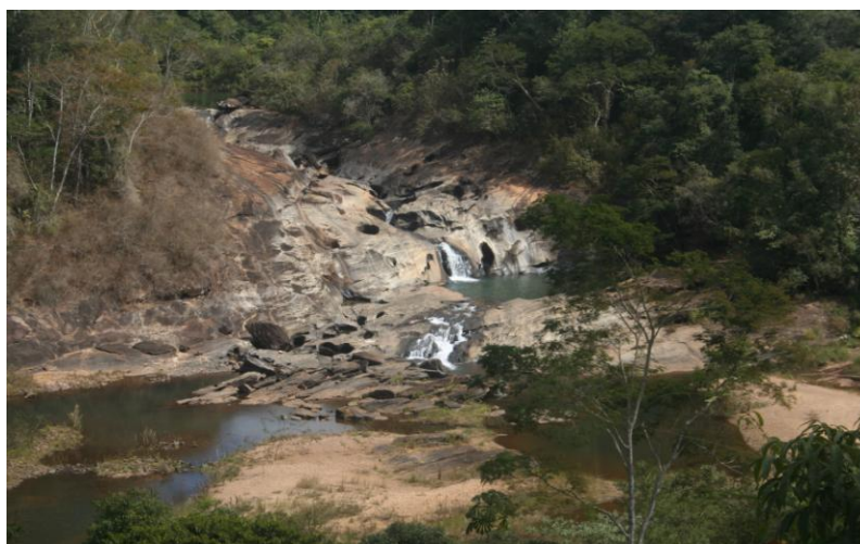
Figura 1. Ao fundo a Cachoeira da Fumaça, após a construção da PCH, mais acima desse local encontra-se o eixo do barramento. Fonte: pesquisa de campo, 2011.
