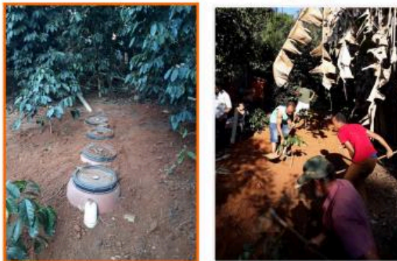
Mutirão de construção de Fossa Biodigestora para tratamento de esgoto em Senhora dos Remédios.
