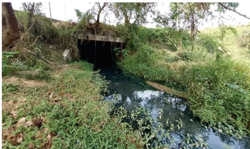
Figura 6 - Ponte construída sobre o curso d'água.
