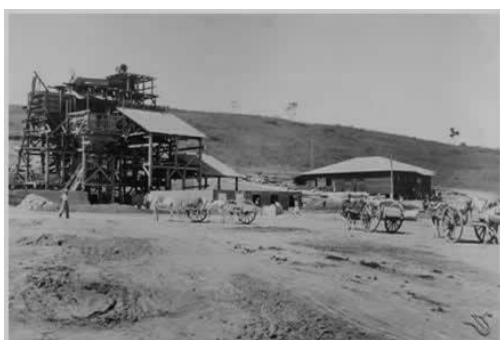
Figura 1 – Construção da Usina 1942. Fonte: http://www.portalvr.com/
