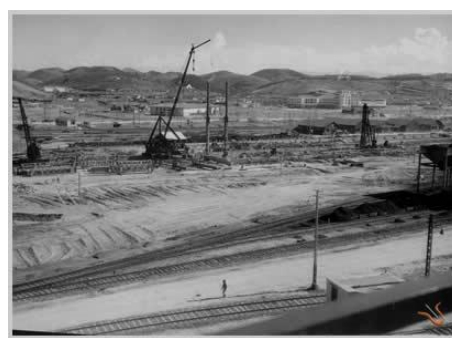
Figura 2 - Construção da Usina. 1942. Fonte: http://www.portalvr.com/
