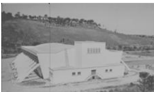
Figura 28 - Ginásio coberto do Recreio dos Trabalhadores. s/d. Fonte: Caderno de Bairros nº 02 – IPPU-Volta Redonda. 2010.
