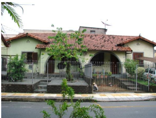
Figura 44 – Casas no bairro Conforto. 2012. Fonte: Acervo Renata Assis.
