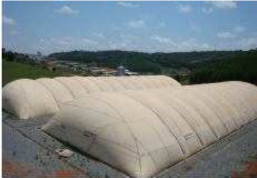
Figura 01 – Vista geral de um biodigestor do modelo tubular “plug-flow”
