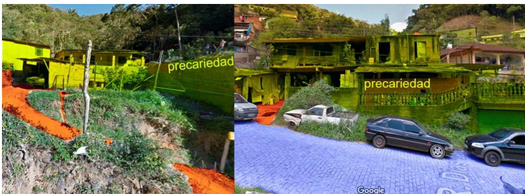
Fotografía 07 – Urbanización de Encostas TIPO 05 – Barrio Duarte da Silveira. Fuente: Street View Google Earth. 2015.
