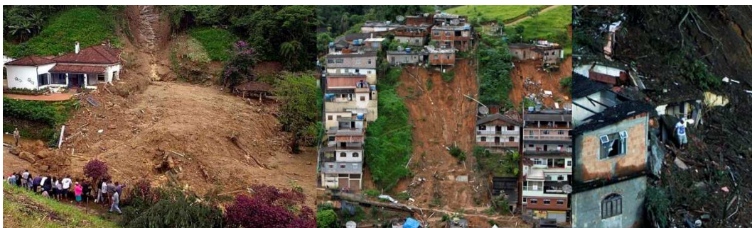
Figura 13 – Deslizamientos en urbanizaciones precarias. 2011. Fuente: Adaptado de www.g1.globo.com
