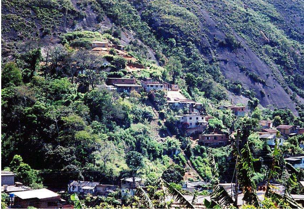
Fotografía 11 –Asentamiento en Encosta . Barrio Roseiral . TIPO 02. Fuente: PMSBP. 2014
