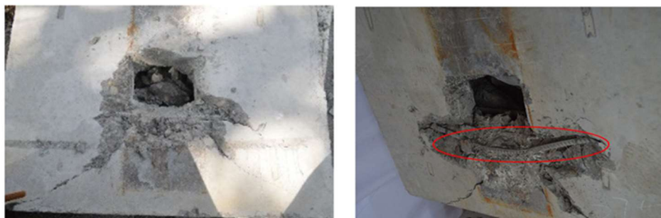
Figura 14 – Esmagamento do concreto e deformação da armadura transversal nos ensaios de Wang et al. (2019).
