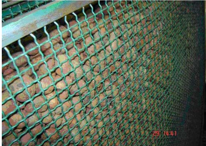
Figura 22 – Detalhes da argila expandida acomodada entre as telas.
