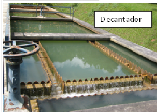
Figura 10 Vista geral e das unidades de mistura rápida, floculação, decantação e filtração da ETA SAAE II
