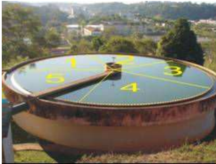
Figura 14 Vista do decantador da ETA UFV com representação das cinco regiões de medição de vazão
