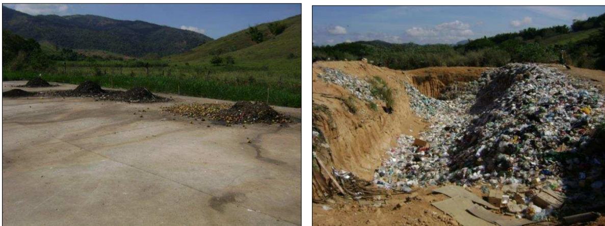
Figura 13. Pátio de compostagem e vala aberta para aterramento de rejeitos de Ipanema
