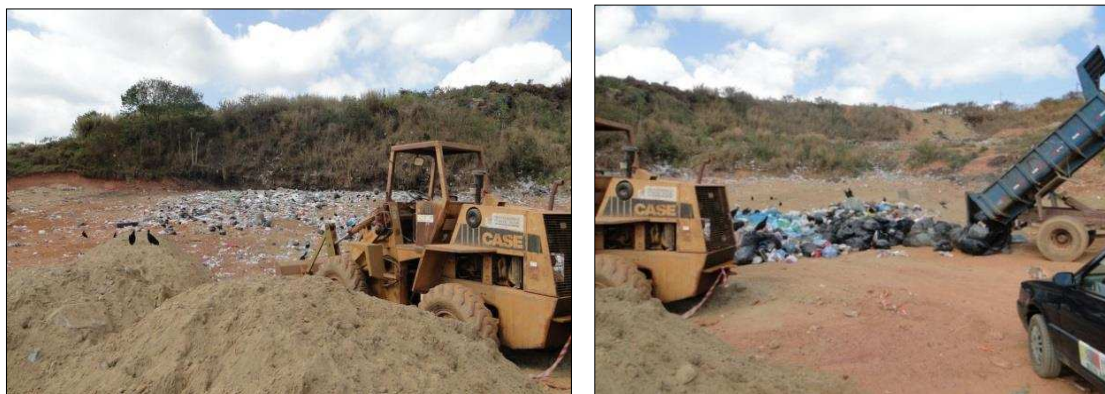
Figura 37. Trator fazendo o recobrimento de resíduos em Ponte Nova
