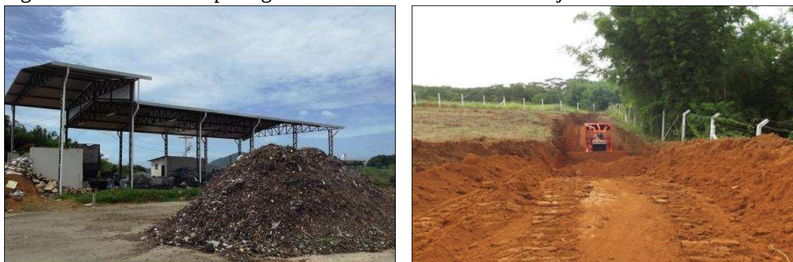
Figura 41. Leira de compostagem e a vala de aterramento de rejeito de Recreio
