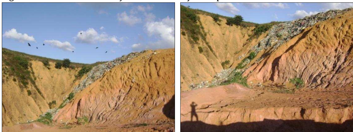
Figura 9. Lixão em área de voçoroca de Conceição de Ipanema
