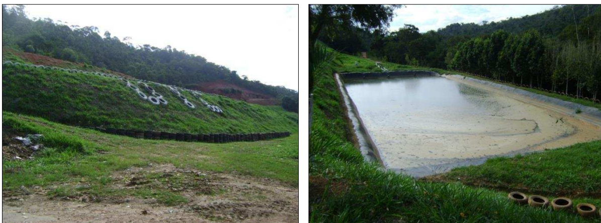
Figura 22. Aterro sanitário e lagoa facultativa para tratamento do efluente do aterro
