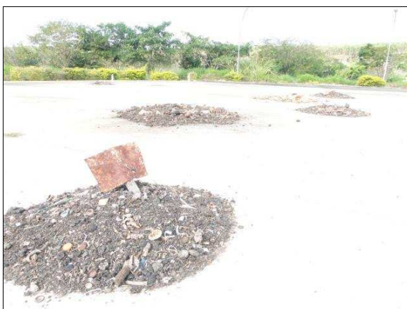
Figura 44. Leira de compostagem vala de aterramento de rejeito de Rio Doce
