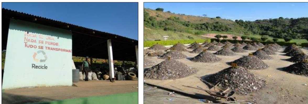
Figura 49. Galpão de Triagem e pátio de compostagem da IRR de Tocantins
