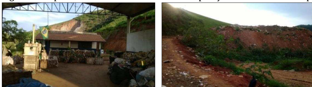
Figura 5. Galpão de armazenamento e área de disposição final de Abre Campo
