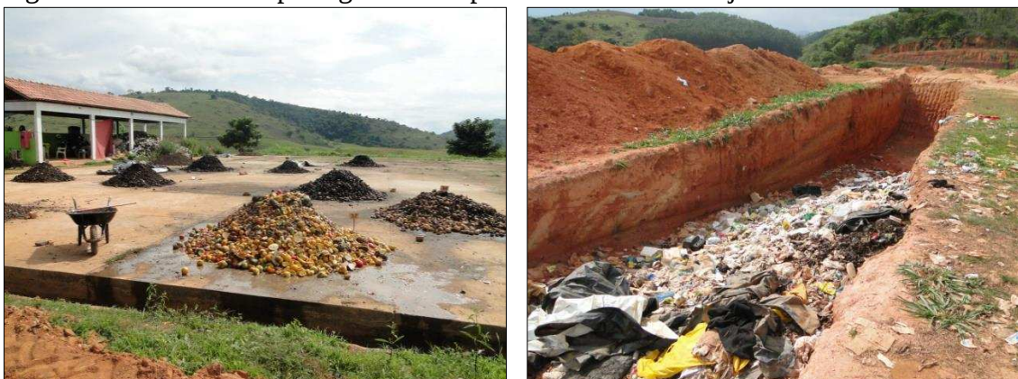
Figura 39. Pátio de compostagem e vala para aterramento de rejeitos de Raul Soares
