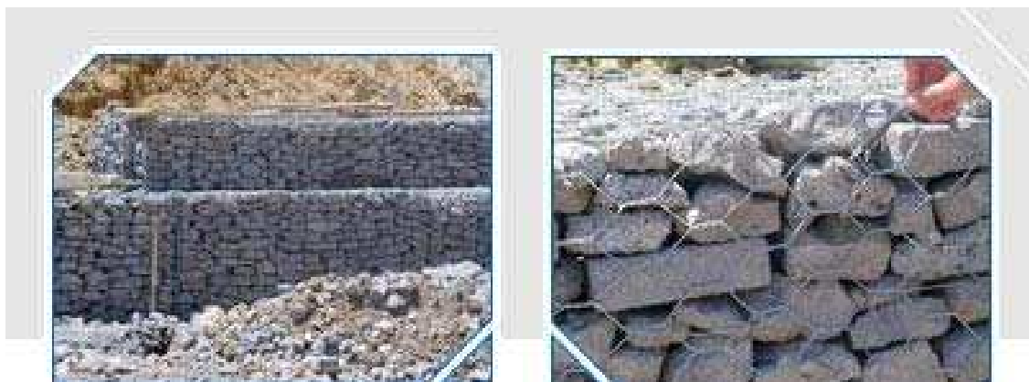
Figura 8 - Obras no Contorno de BR 393 em Volta Redonda - R.J. (CST, 2012)
