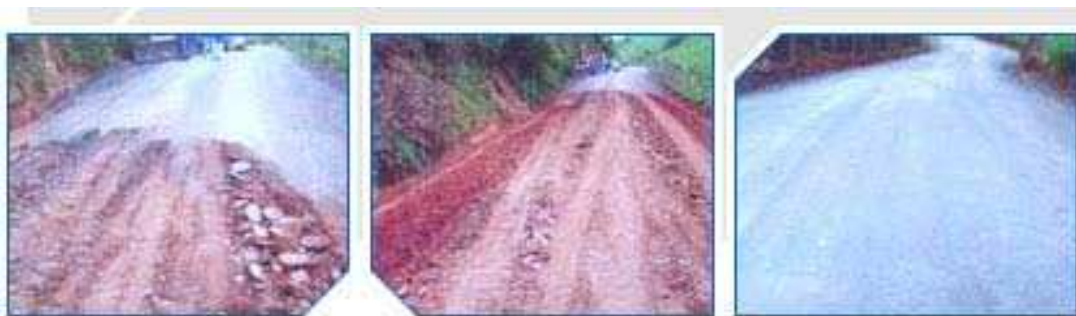
Figura 6 - Utilização de escória de aciaria em vias urbanas e rurais (CST, 2012)
