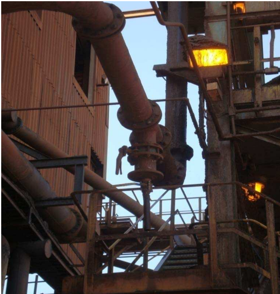
Figura 14 - Vista inferior do cone desaguador e ponto de amostragem do rejeito denominado "concentração magnética".
