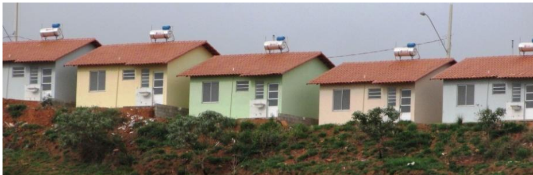
Figura 42 – Conjunto habitacional do PMCMV - Loteamento Novo Triunfo II Fonte: Arquivo pessoal, 2014.
