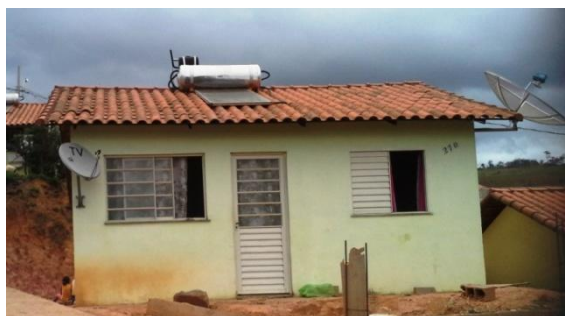
Figura 18 – Conjunto habitacional do PMCMV Painel solar da unidade habitacional Fonte: Arquivo pessoal da autora, 2014.
