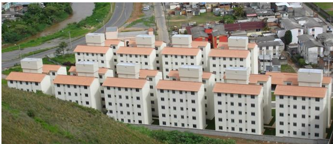
Figura 13 – Conjunto habitacional do PMCMV Residencial Belo Vale II Fonte: VALOR ENGENHARIA, [2014b].
