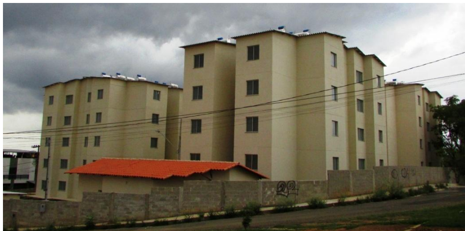
Figura 40 – Conjunto habitacional do PMCMV Residencial Santa Maria Fonte: Arquivo pessoal da autora, 2014.
