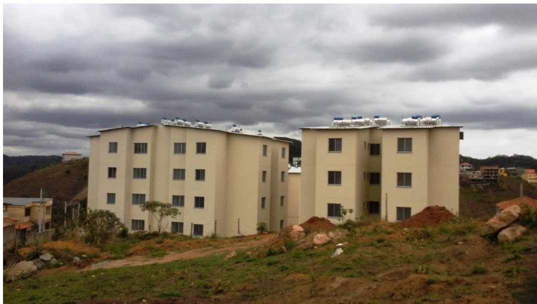
Figura 28 – Conjunto habitacional do PMCMV Residencial Vitória Fonte: Arquivo pessoal da autora, 2014.
