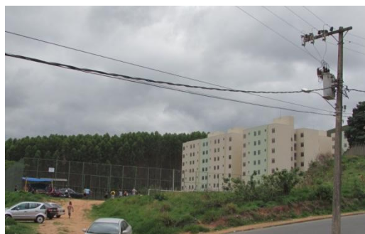
Figura 39 – Quadra esportiva descoberta ao lado do conjunto habitacional Fonte: Arquivo pessoal da autora, 2014.
