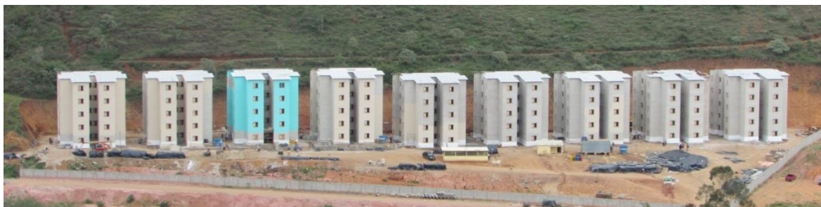
Figura 3 – Conjunto Habitacional Parque das Águas II do PMCMV em Juiz de Fora, composto por 14 edifícios idênticos com cinco andares cada e 280 apartamentos multifamiliares Fonte: Arquivo pessoal da autora, 2014.
