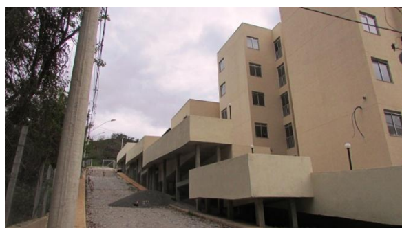
Figura 37 – Rampa de acesso ao residencial e rampa de acesso ao estacionamento Fonte: Arquivo pessoal da autora, 2014.
