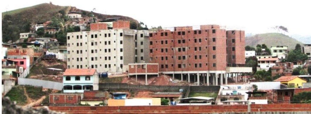
Figura 46 – Conjunto habitacional do PMCMV Residencial Parque Independência Fonte: Arquivo pessoal da autora, 2014.
